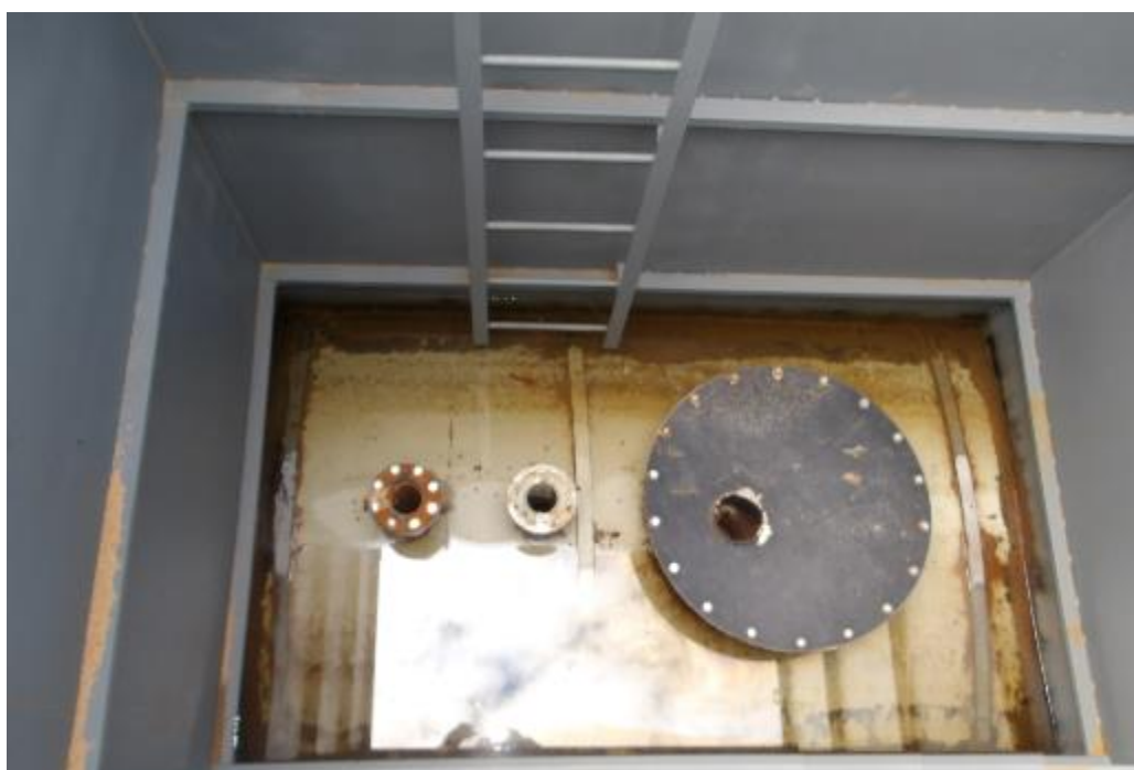
Рисунок 3 – Горловины резервуара РГСп-75 зав.№ 1393/1
