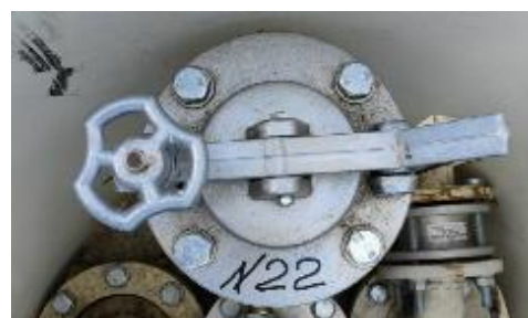
Рисунок 3 – Замерные люки резервуара
