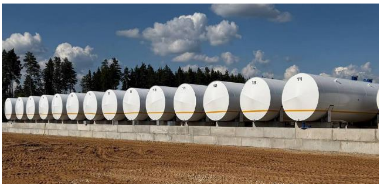
Рисунок 2 – Общий вид резервуаров РГСн-50
