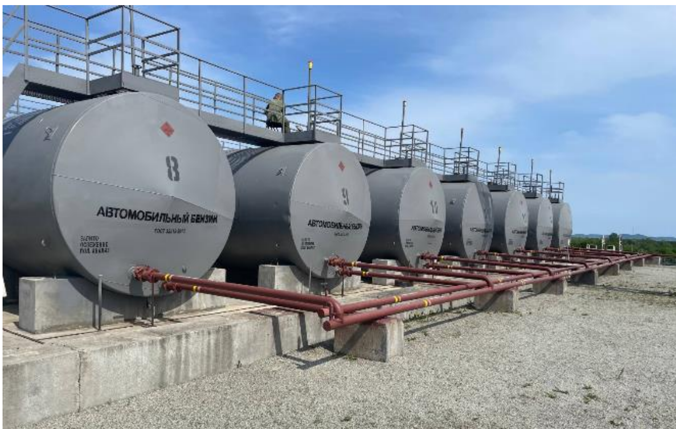
Рисунок 2 – Общий вид резервуаров Р-75 с зав. №№ 8, 9, 10, 11, 12, 13, 14
