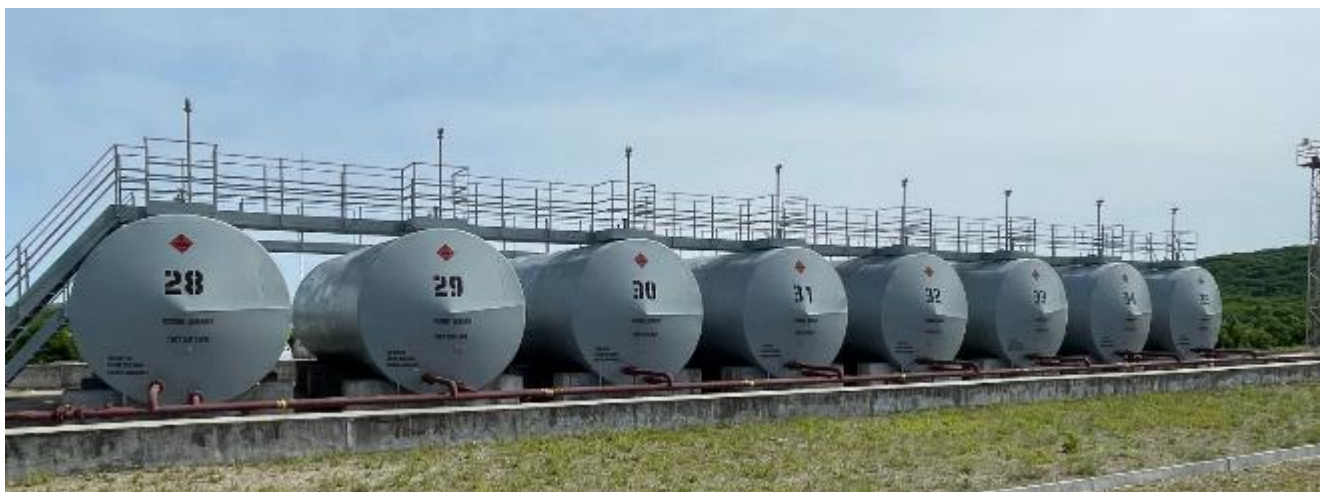
Рисунок 3 – Общий вид резервуаров Р-75 с зав. №№ 28, 29, 30, 31, 32, 33, 34, 35
