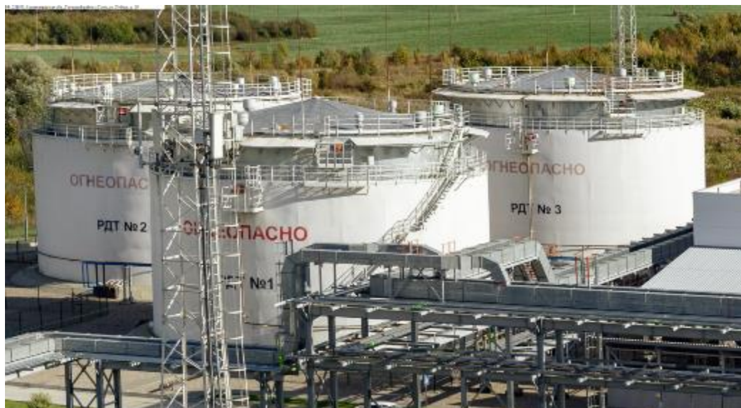
Рисунок 1 – Общий вид резервуаров стальных вертикальных цилиндрических РВС-5000
