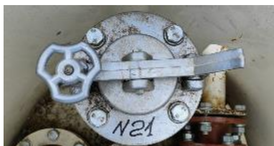
Рисунок 3 – Замерные люки резервуара
