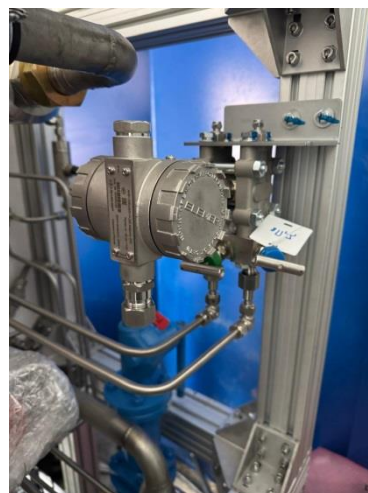
Рисунок 16 – Преобразователь давления измерительный АИР-20/М2 в месте установки
