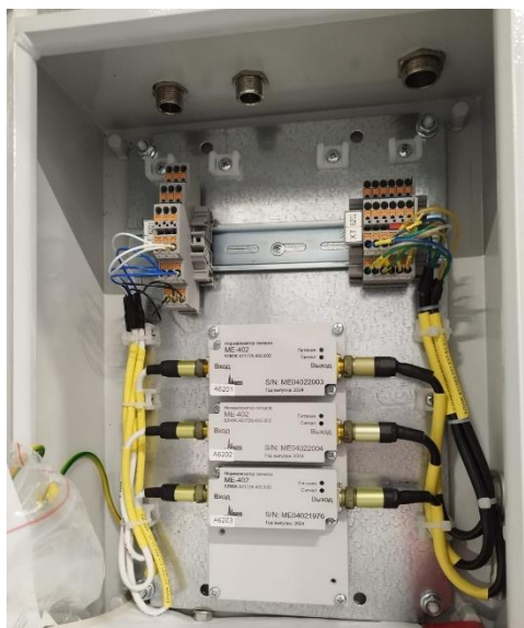
Рисунок 13 – Нормализаторы сигналов ME-402 в шкафу нормализаторов ШН2.1. Вид внешний
