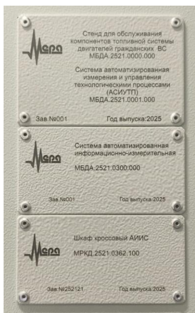
Рисунок 7 – Заводская маркировка шкафа кроссового АИИС
