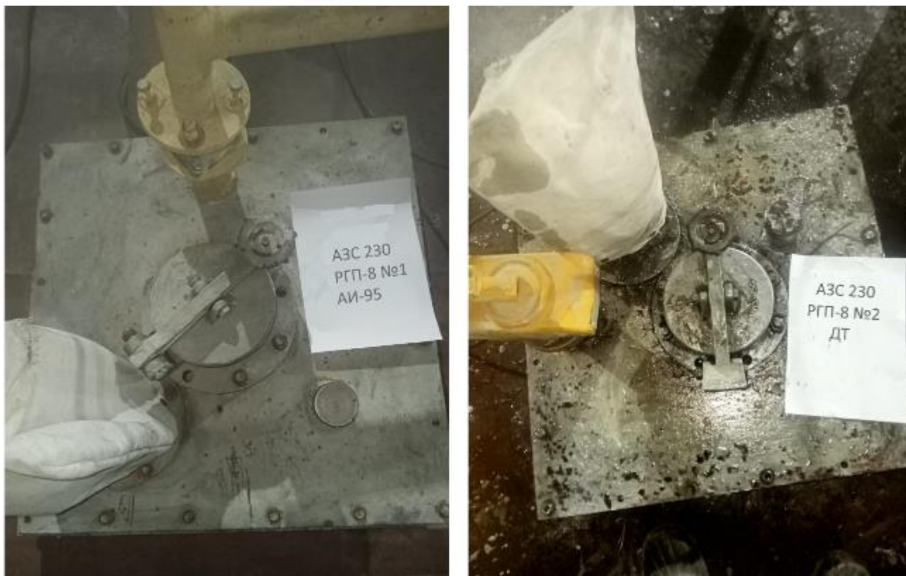
Рисунок 2 – Горловины резервуаров РГП-8 зав.№№ 1, 2
