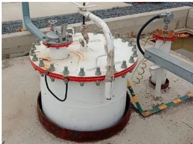
Рисунок 3 – Горловины и измерительный люк резервуара ЕП-40-2400-1200-А-С-У1 зав.№ 361 Пломбирование резервуара ЕП-40-2400-1200-А-С-У1 не предусмотрено
