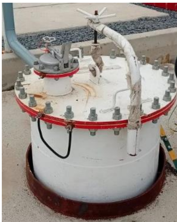
Рисунок 3 – Горловина и измерительный люк резервуара ЕП-40-2400-1200-А-С-У1 зав.№ 360 Пломбирование резервуара ЕП-40-2400-1200-А-С-У1 не предусмотрено
