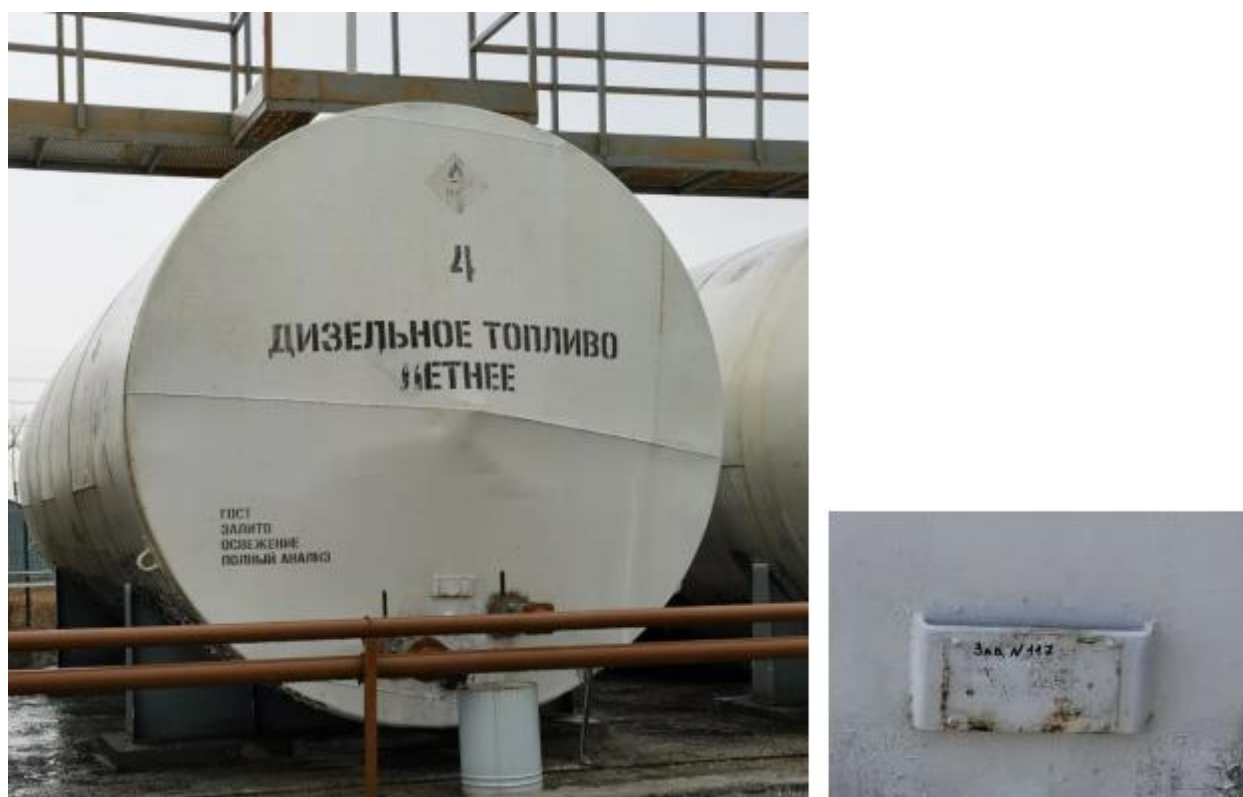
Рисунок 10 - Общий вид резервуаров РГС-75 зав. № 117 с местом нанесения заводского номера
