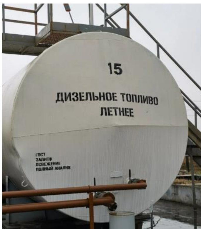
Рисунок 8 - Общий вид резервуаров РГС-75 зав. № 48 с местом нанесения заводского номера
