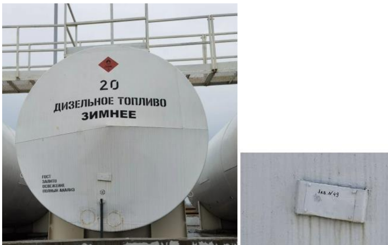
Рисунок 9 - Общий вид резервуаров РГС-75 зав. № 49 с местом нанесения заводского номера
