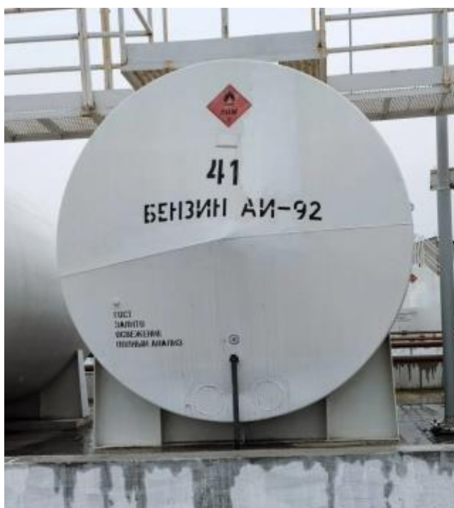
Рисунок 1 - Общий вид резервуаров РГС-25 зав. № 168 с местом нанесения заводского номера
