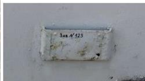
Рисунок 13 - Общий вид резервуаров РГС-75 зав. № 123 с местом нанесения заводского номера
