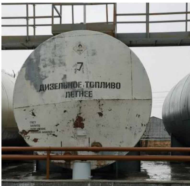
Рисунок 3 - Общий вид резервуаров РГС-75 зав. № 37 с местом нанесения заводского номера
