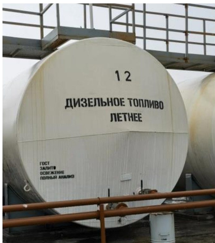
Рисунок 17 - Общий вид резервуаров РГС-75 зав. № 871 с местом нанесения заводского номера
