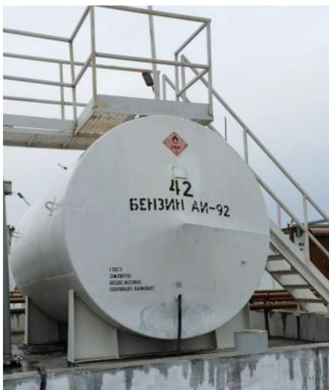
Рисунок 2 - Общий вид резервуаров РГС-25 зав. № 788 с местом нанесения заводского номера
