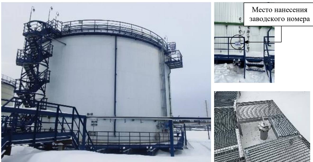
Рисунок 1 - Общий вид резервуара зав. № 256 с указанием места нанесения заводского номера, общий вид замерного люка
