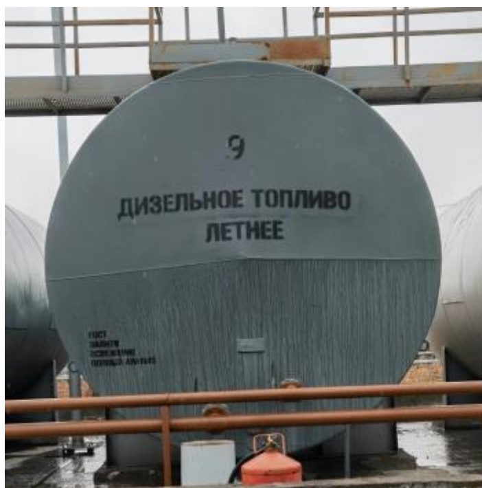
Рисунок 14 - Общий вид резервуаров РГС-75 зав. № 847 с местом нанесения заводского номера
