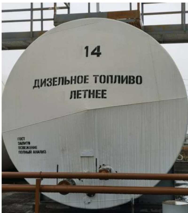
Рисунок 15 - Общий вид резервуаров РГС-75 зав. № 866 с местом нанесения заводского номера
