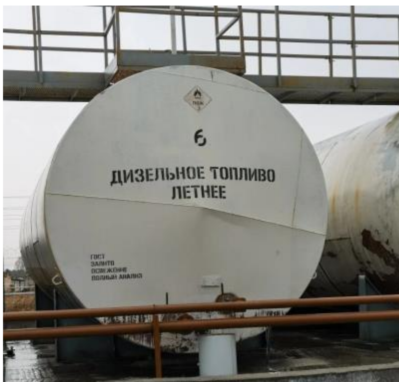
Рисунок 13 - Общий вид резервуаров РГС-75 зав. № 123 с местом нанесения заводского номера
