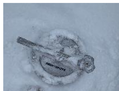
Рисунок 1 - Общий вид резервуара зав. № 6.8.1 с указанием места нанесения заводского номера, общий вид замерного люка
