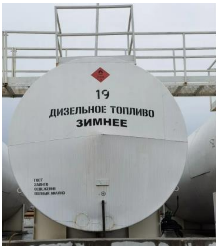
Рисунок 6 - Общий вид резервуаров РГС-75 зав. № 44 с местом нанесения заводского номера
