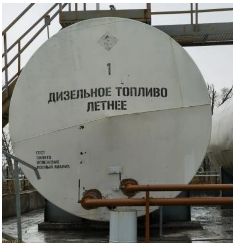
Рисунок 7 - Общий вид резервуаров РГС-75 зав. № 45 с местом нанесения заводского номера
