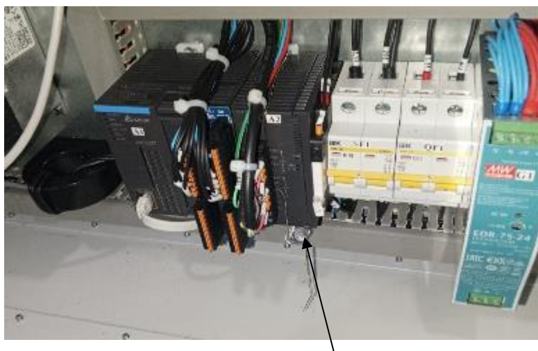
Рисунок 2 — Место пломбирования
