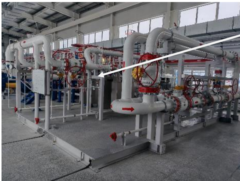
Рисунок 1 – Общий вид СИКНС и место крепления маркировочной таблички
