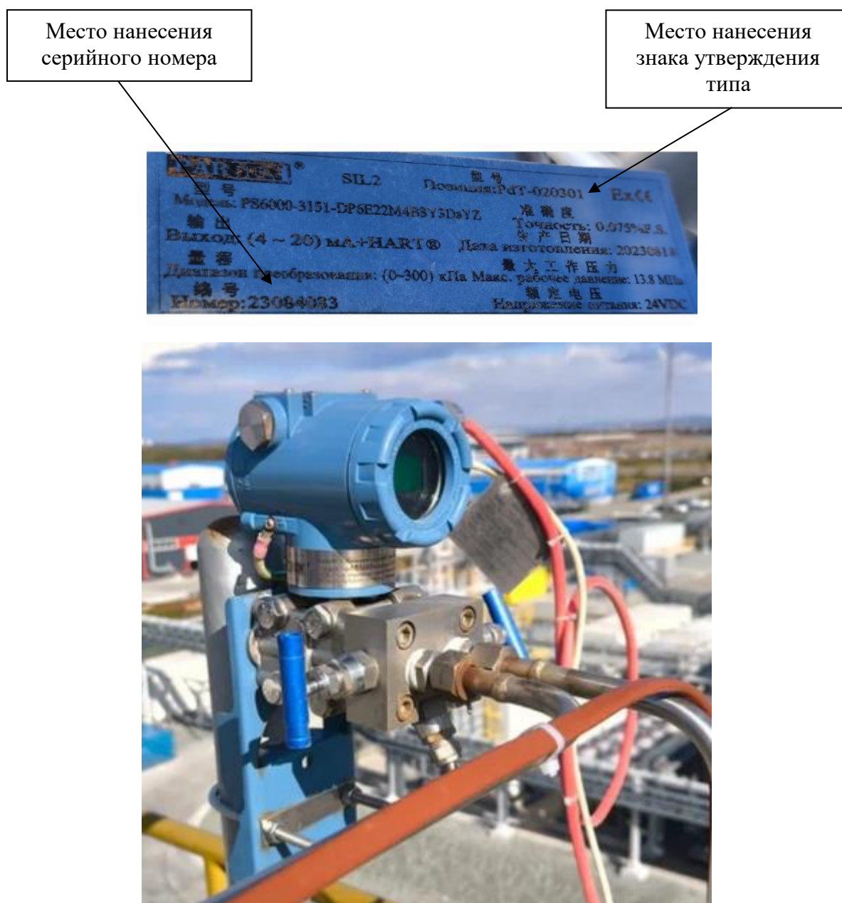
Рисунок 1 – Общий вид датчиков с указанием места нанесения знака утверждения типа, места нанесения серийного номера
