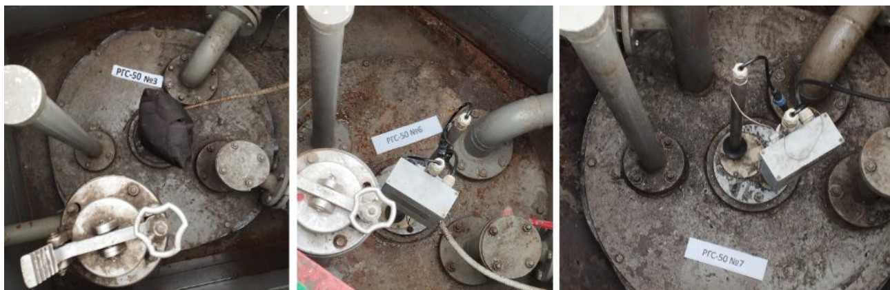
Рисунок 4 – Горловины резервуаров РГС-50 зав.№№ 3, 6, 7
