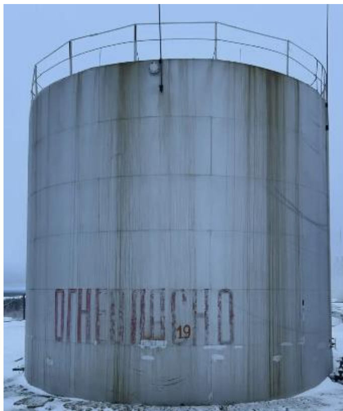
Рисунок 1 – Общий вид резервуара РВС-700 № 19
