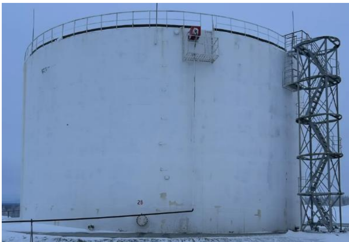
Рисунок 2 – Общий вид резервуара РВС-5000 № 28
