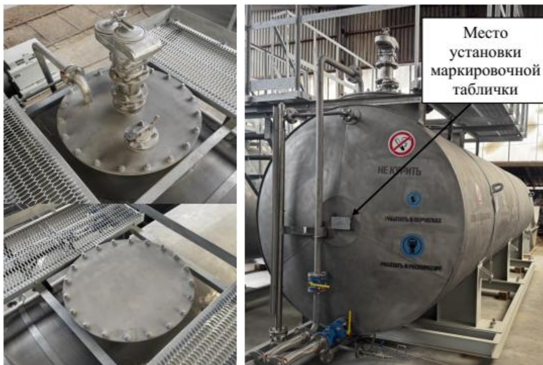
Рисунок 2 – Общий вид резервуара
