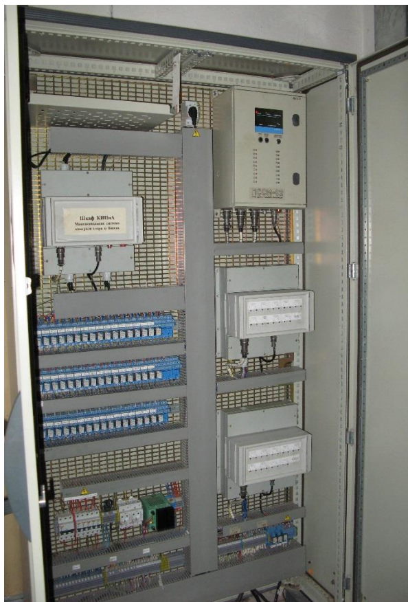
Рисунок 2 – Внешний вид системы контроля концентрации хлора многоканальной СКХ в исполнении ПСОИ-02 с блоком трансляции и блоком управления сигнализацией
