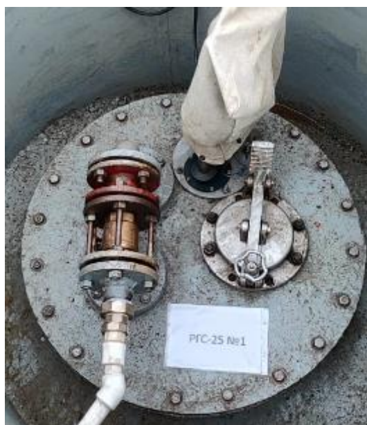
Рисунок 3 – Горловина резервуара РГС-25 зав.№ 1
