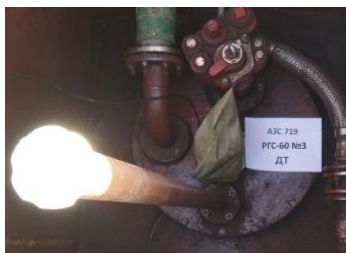
Рисунок 5 – Горловина резервуара РГС-60 зав.№ 3
