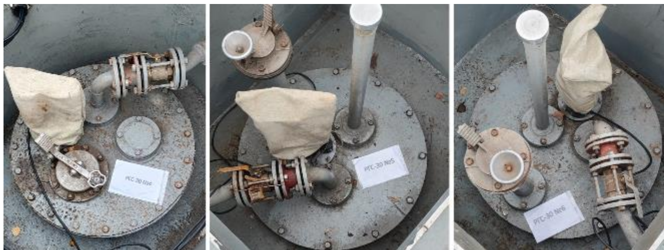
Рисунок 4 – Горловины резервуаров РГС-30 зав.№№ 4, 5, 6
