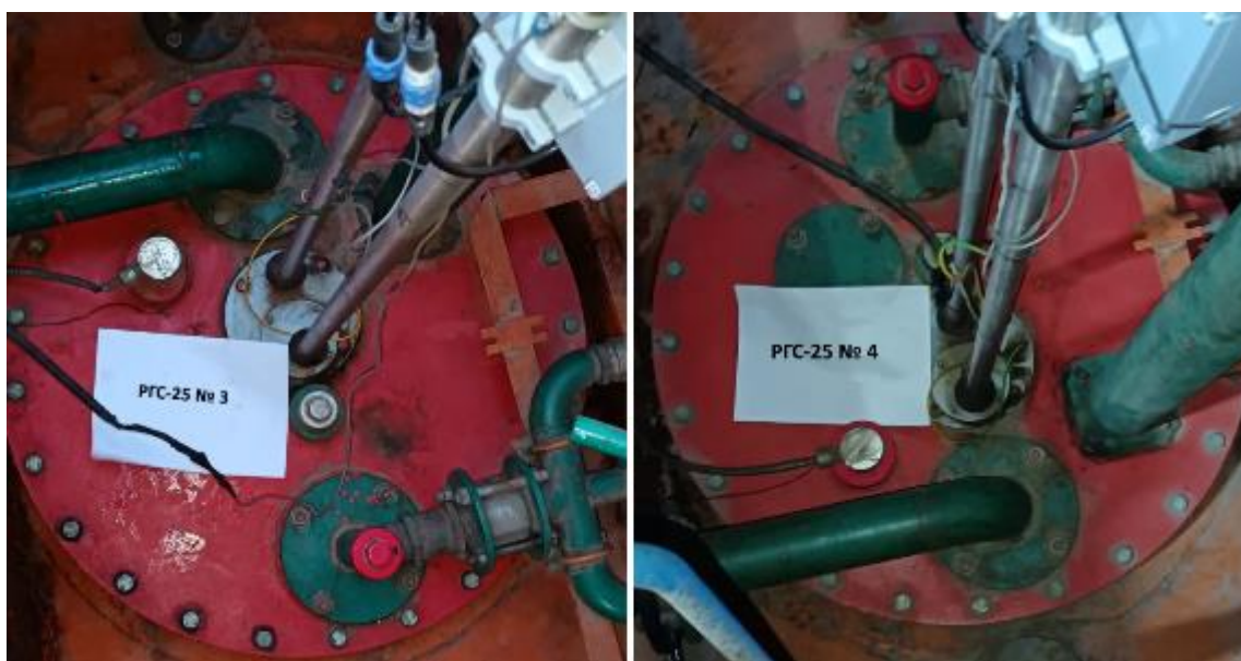
Рисунок 2 – Горловины резервуаров РГС-25 зав.№№ 3, 4
