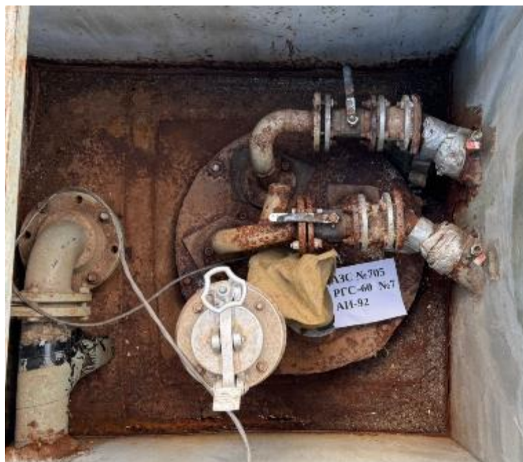
Рисунок 6 – Горловина резервуара РГС-60 зав.№ 7
