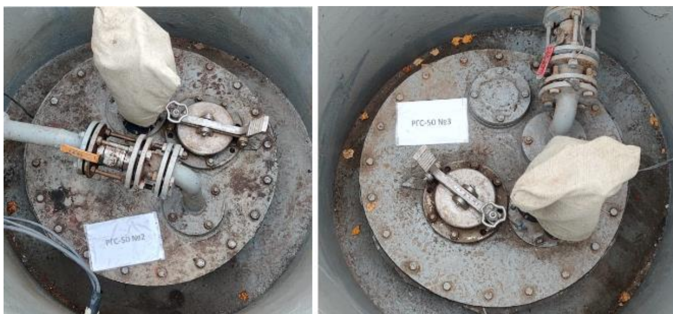
Рисунок 5 – Горловины резервуаров РГС-50 зав.№№ 2, 3
