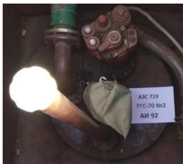
Рисунок 6 – Горловина резервуара РГС-70 зав.№ 2
