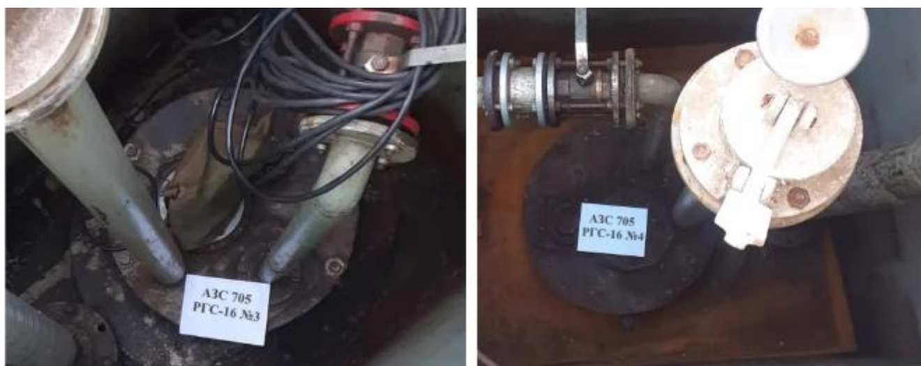
Рисунок 4 – Горловины резервуаров РГС-16 зав.№№ 3, 4
