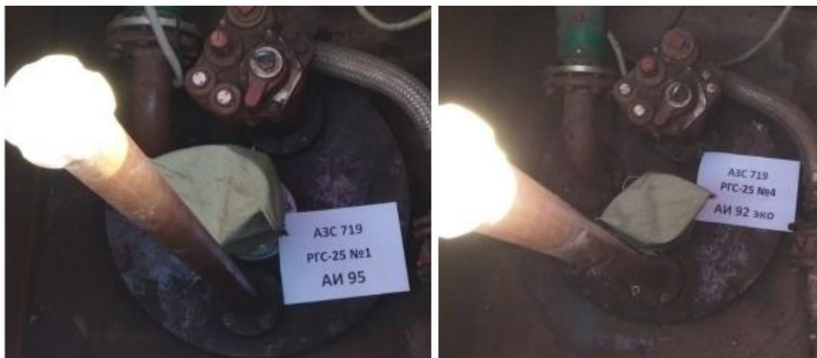
Рисунок 4 – Горловины резервуаров РГС-25 зав.№№ 1, 4
