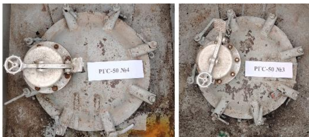
Рисунок 2 – Горловины резервуаров РГС-50 зав.№№ 3, 4
