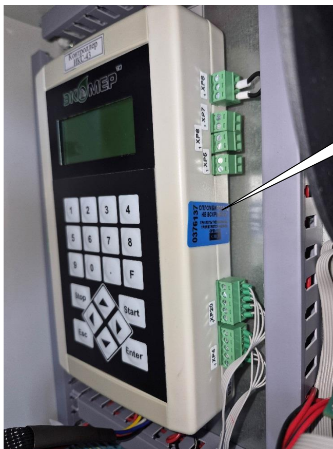
Рисунок 4 – Место нанесения пломбы на корпусе контроллера для исполнений ИКТС-11 и ИКТС-11.1
