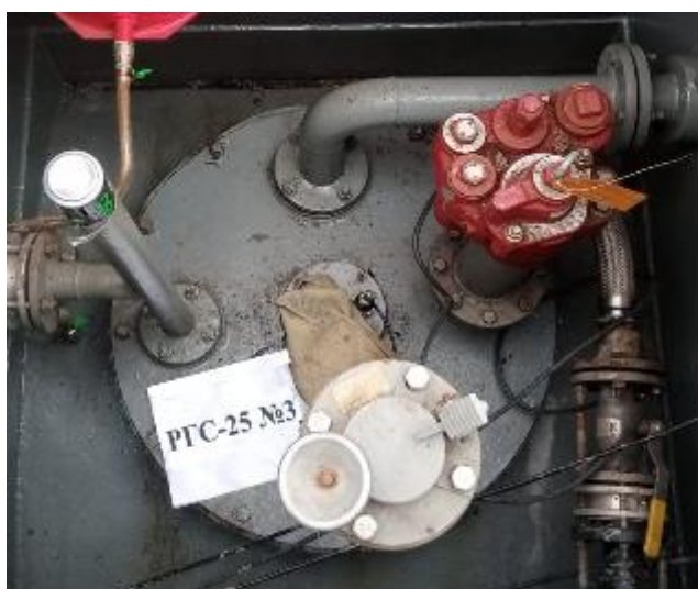
Рисунок 3 – Горловины резервуаров РГС-25 зав.№№ 3, 4
