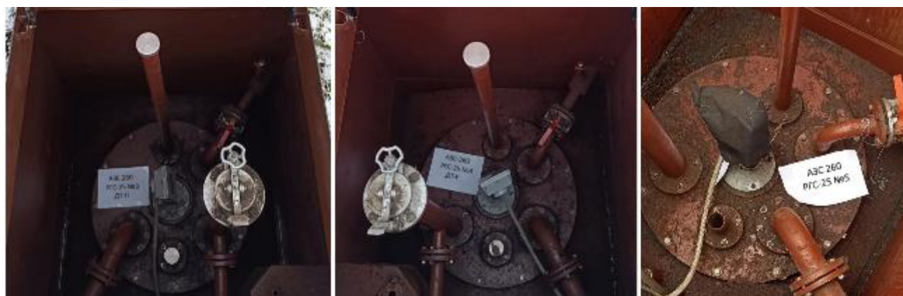
Рисунок 3 – Горловины резервуаров РГС-25 зав.№№ 3, 4, 5
