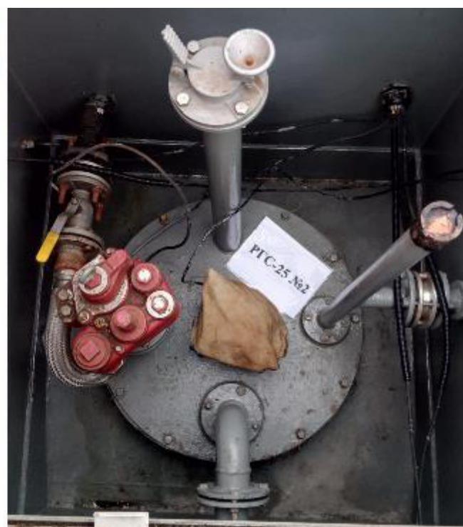
Рисунок 2 – Горловины резервуаров РГС-25 зав.№№ 1, 2
