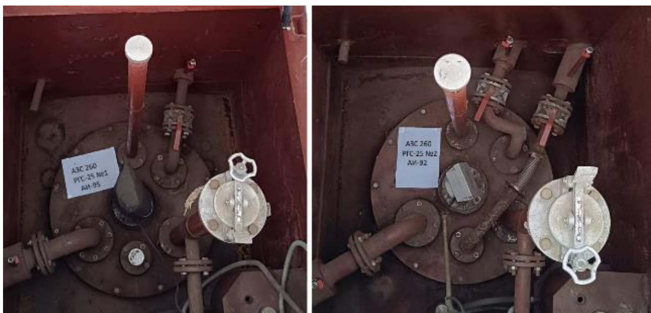
Рисунок 2 – Горловины резервуаров РГС-25 зав.№№ 1, 2
