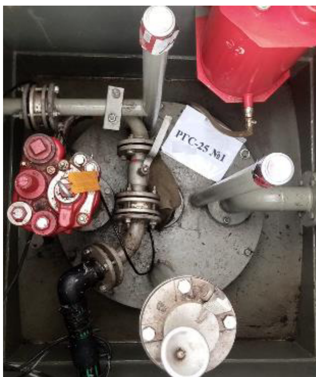
Рисунок 2 – Горловины резервуаров РГС-25 зав.№№ 1, 2
