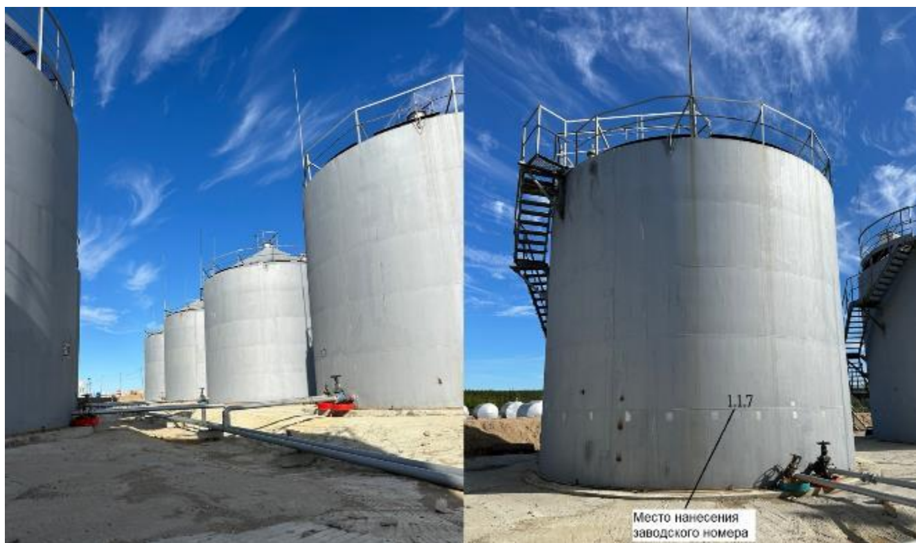
Рисунок 1 – Общий вид резервуаров вертикальных стальных цилиндрических РВС-400 с указанием места нанесения заводских номеров
