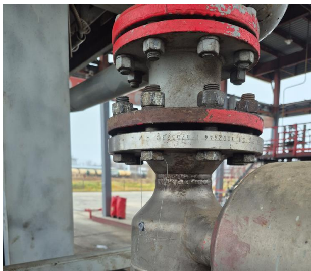
Рисунок 7 – Схема пломбировки фланцев счетчиков-расходомеров массовых
