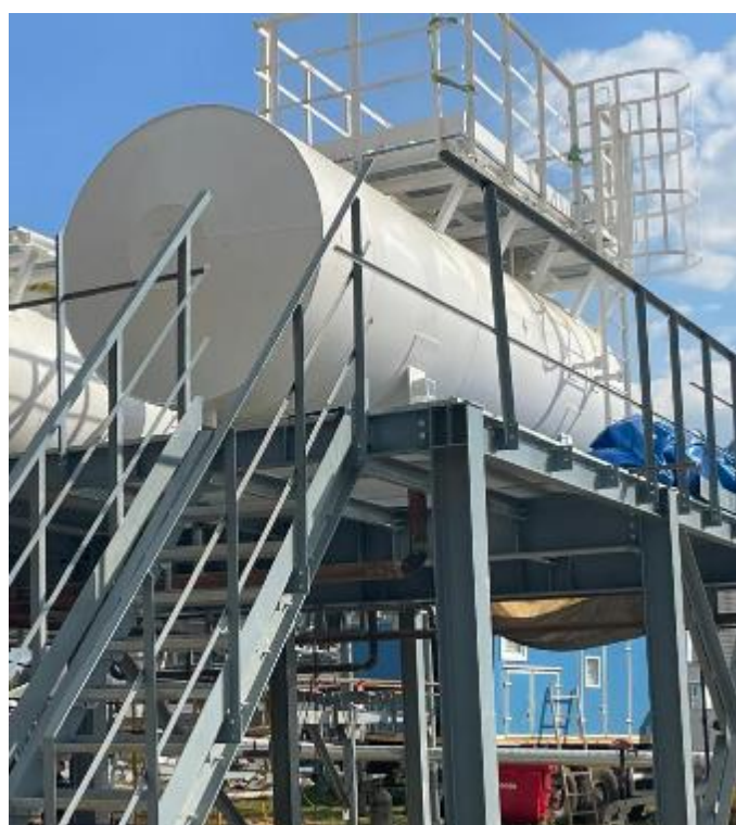
Рисунок 2 – Общий вид резервуара РГС-20(17/3)-П2-А-Т-С0-УХЛ1 с зав.№ 171.11.24
