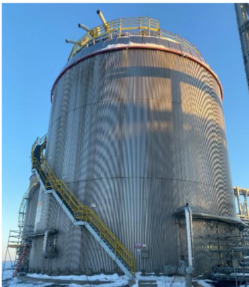
Рисунок 2 – Общий вид резервуара РВС-5000
