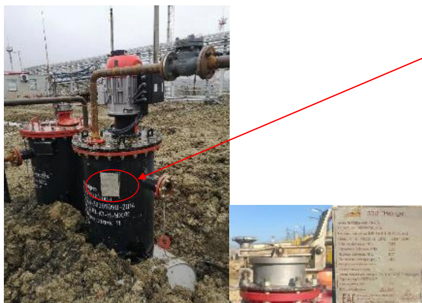
Рисунок 2 – Общий вид заливной горловины, замерного люка и информационной таблички М-ЕП8 зав.№ 2608
