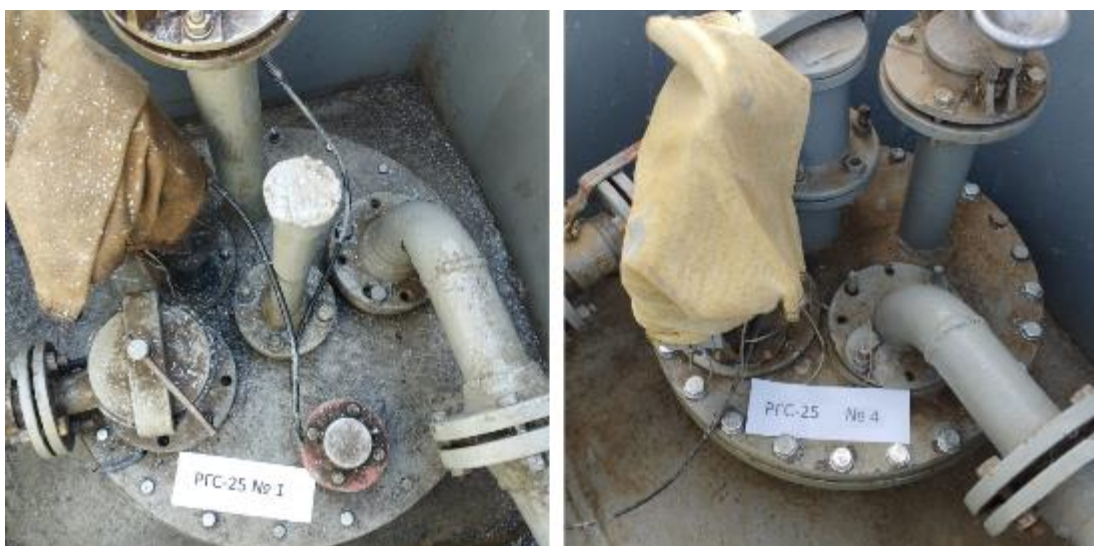
Рисунок 3 – Горловины резервуаров РГС-25 зав.№№ 1, 4
