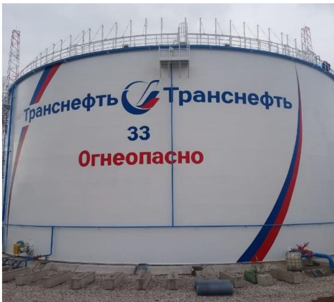
Рисунок 1 – Общий вид резервуара РВСП-30000 № 33
