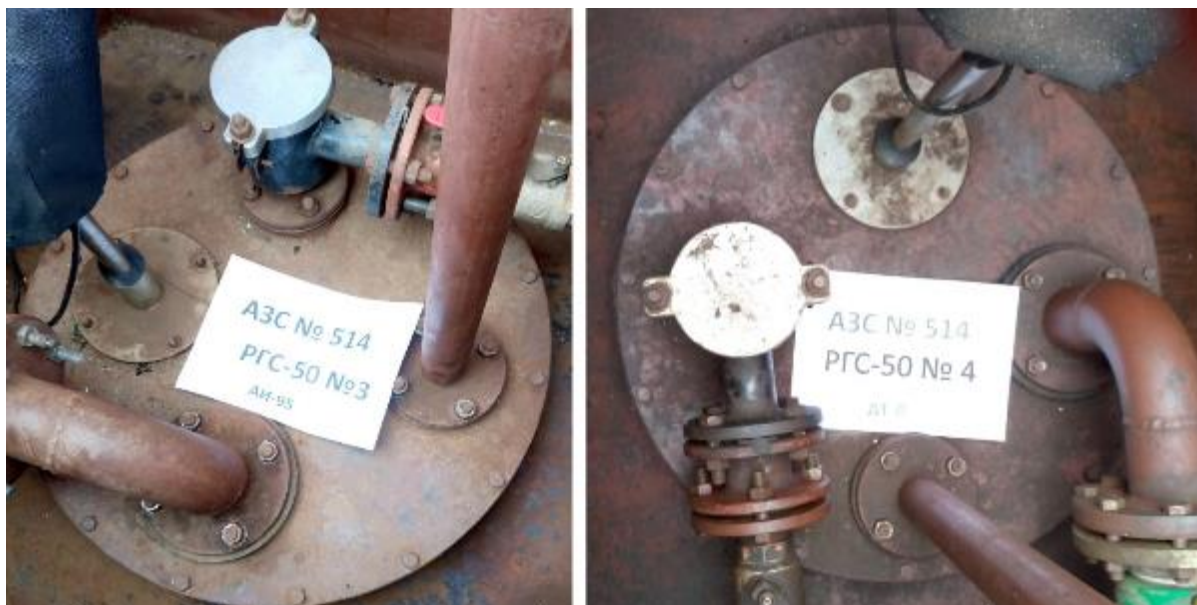
Рисунок 3 – Горловины резервуаров РГС-50 зав.№№ 3, 4
