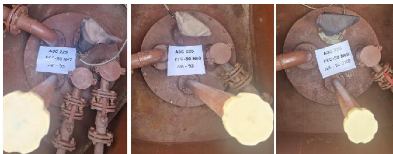
Рисунок 4 – Горловины резервуаров РГС-50 зав.№№ 7, 8, 9
