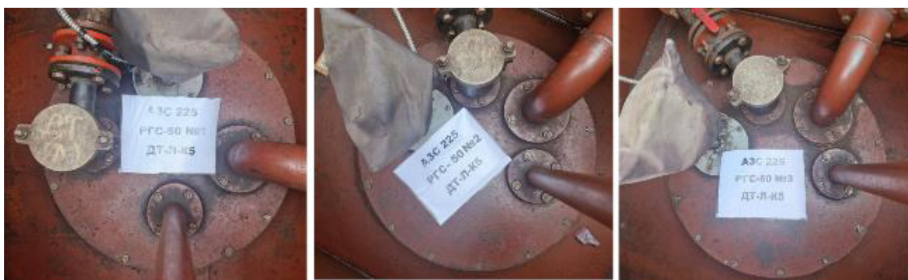
Рисунок 2 – Горловины резервуаров РГС-50 зав.№№ 1, 2, 3
