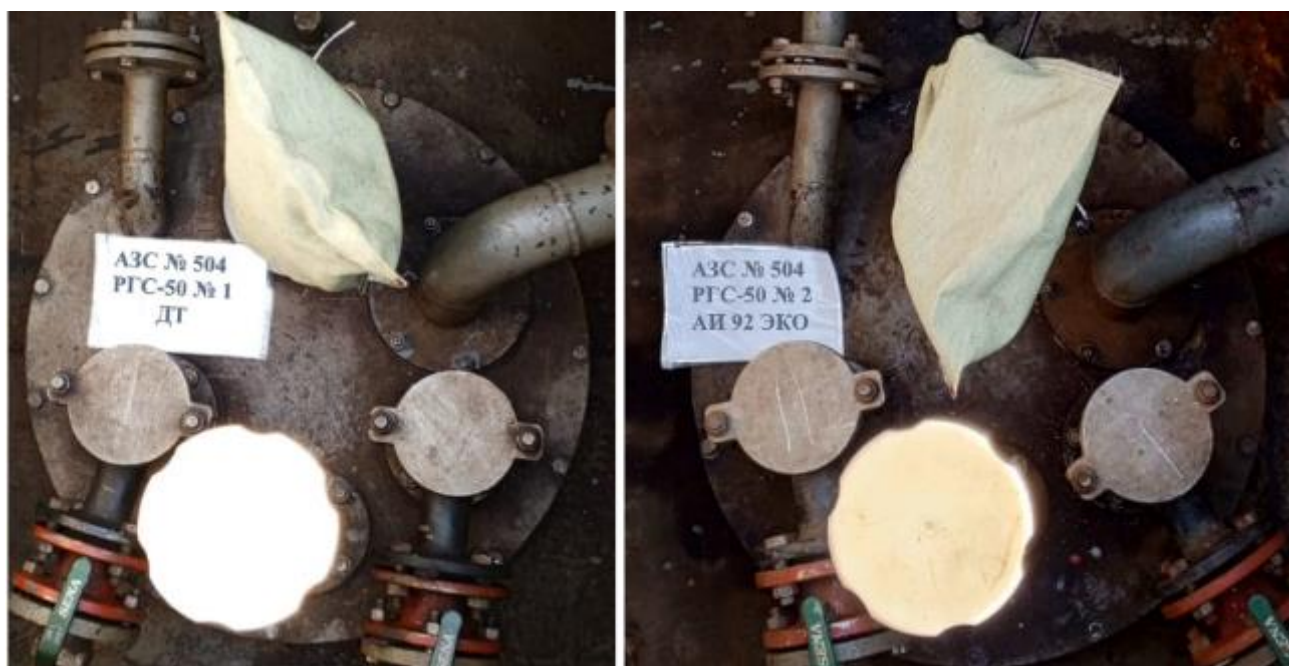
Рисунок 2 – Горловины резервуаров РГС-50 зав.№№ 1, 2
