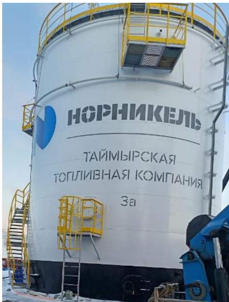
Рисунок 2 – Общий вид резервуара РВСП-1000 № 3а
