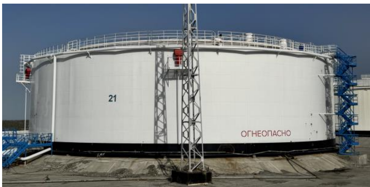
Рисунок 2 – Общий вид резервуара РВС-20000 № 21
