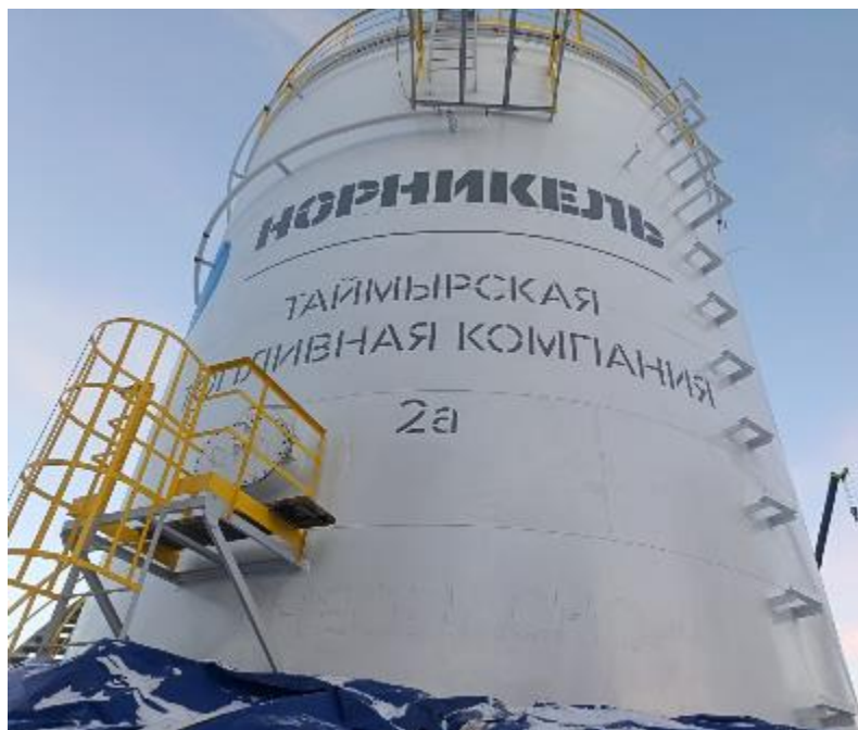
Рисунок 1 – Общий вид резервуара РВСП-1000 № 2а
