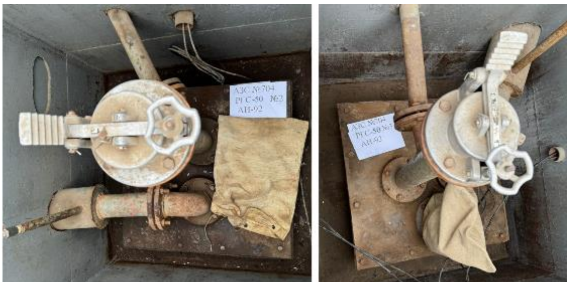
Рисунок 4 – Горловины резервуаров РГС-50 зав.№№ 2, 3
