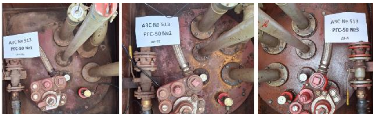
Рисунок 2 – Горловины резервуаров РГС-50 зав.№№ 1, 2, 3
