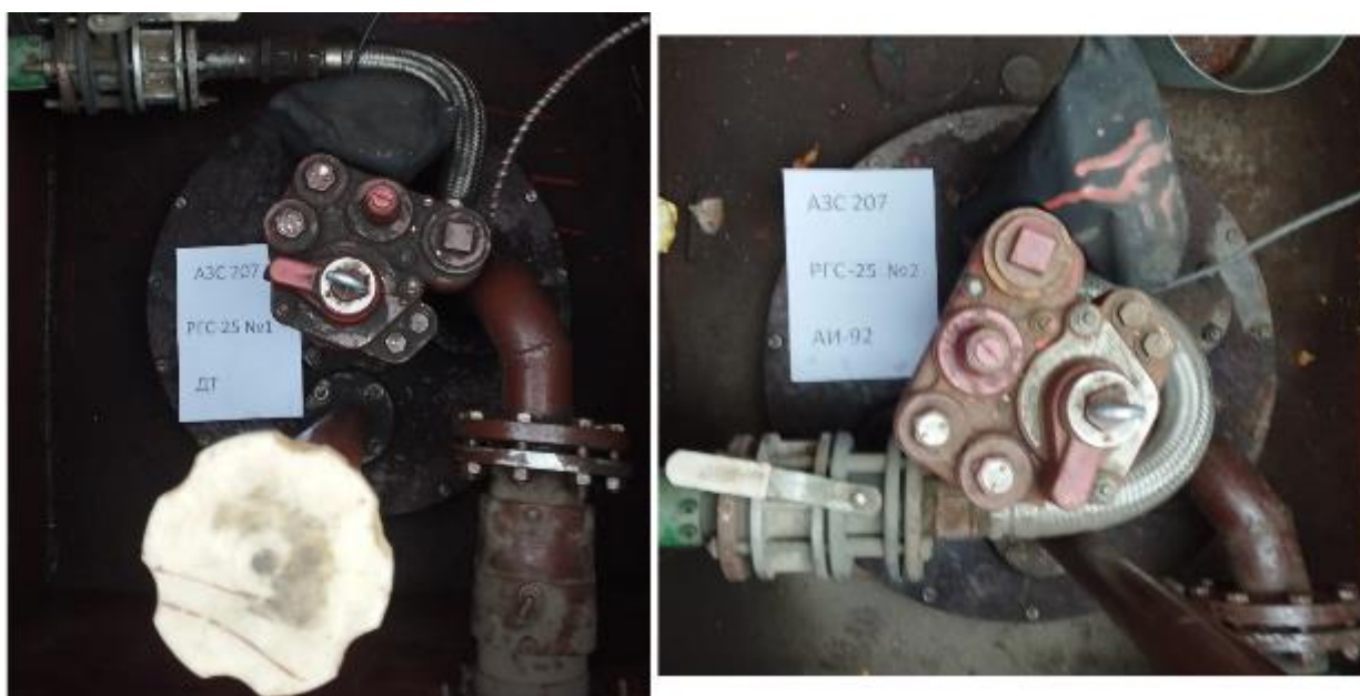
Рисунок 3 – Горловины резервуаров РГС-25 зав.№№ 1, 2
