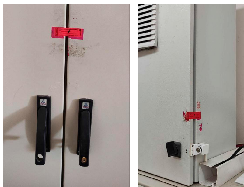
Рисунок 5 – Схема пломбировки шкафа программируемого контроллера Simatic S7-400 от несанкционированного доступа
