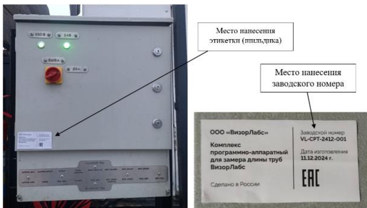
Рисунок 5 – Общий вид коммутационного модуля с указанием места нанесения этикетки (шильдика) и заводского номера
