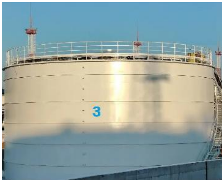
Рисунок 1 – Общий вид резервуара РВС-5000
