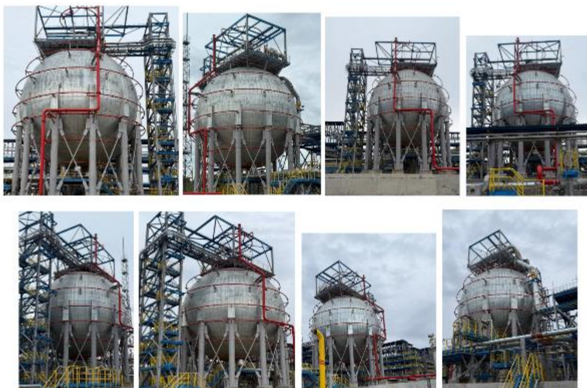
Рисунок 2 – Общий вид резервуаров РШС-2400
