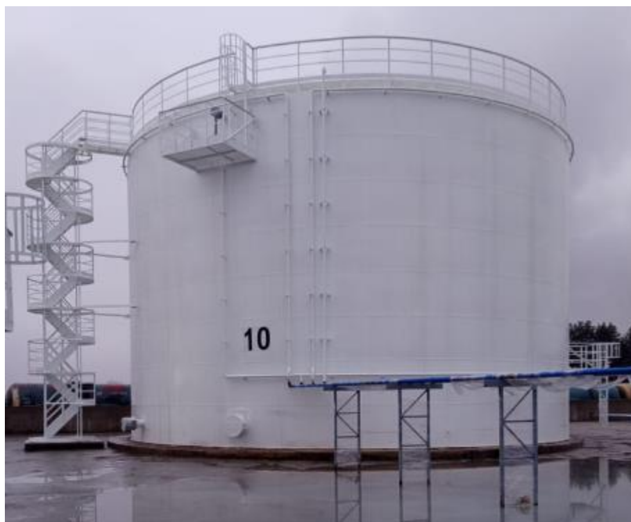
Рисунок 2 – Общий вид резервуара РВСП-3500 № 10
