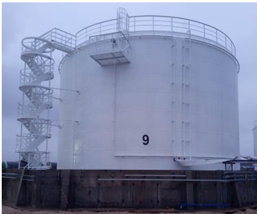
Рисунок 1 – Общий вид резервуара РВСП-3500 № 9
