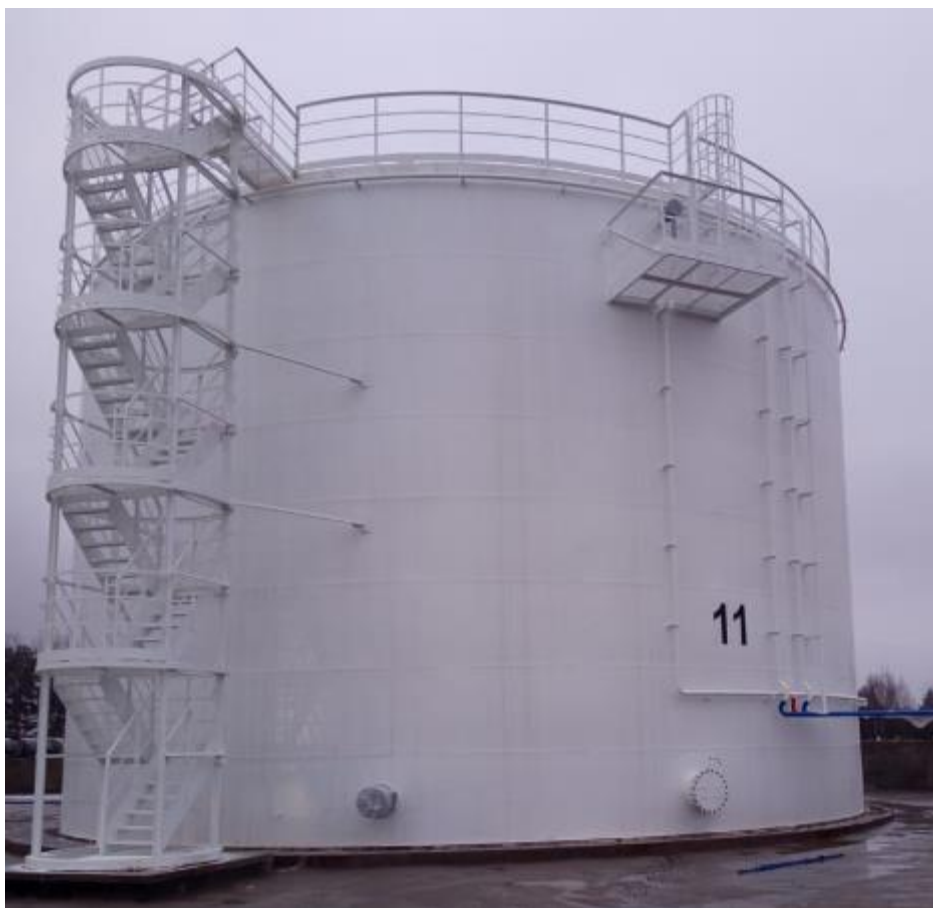
Рисунок 3 – Общий вид резервуара РВСП-3500 № 11
