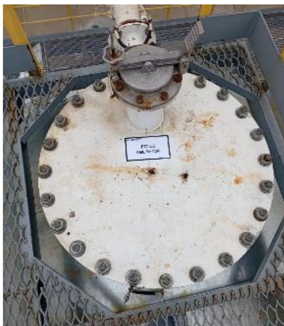
Рисунок 2 – Фотография маркировочной таблички, горловины и крышки замерного люка резервуара
