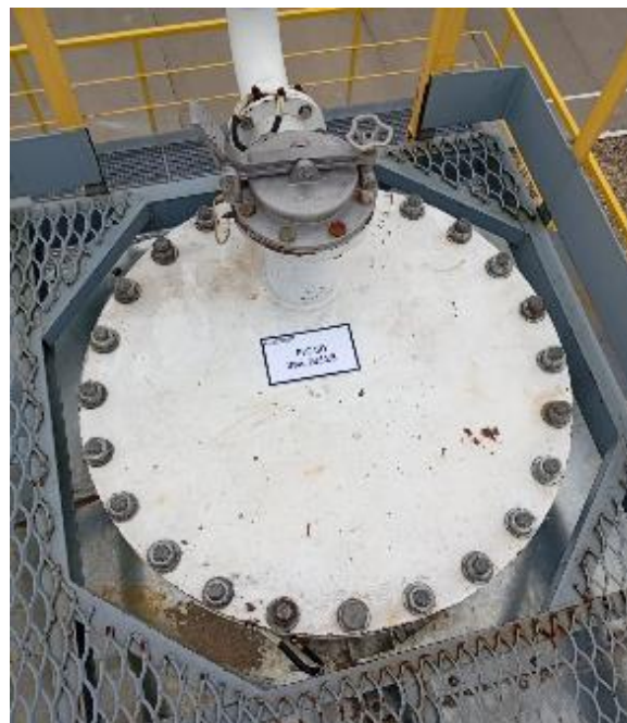
Рисунок 2 – Фотография маркировочной таблички, горловины и крышки замерного люка резервуара
