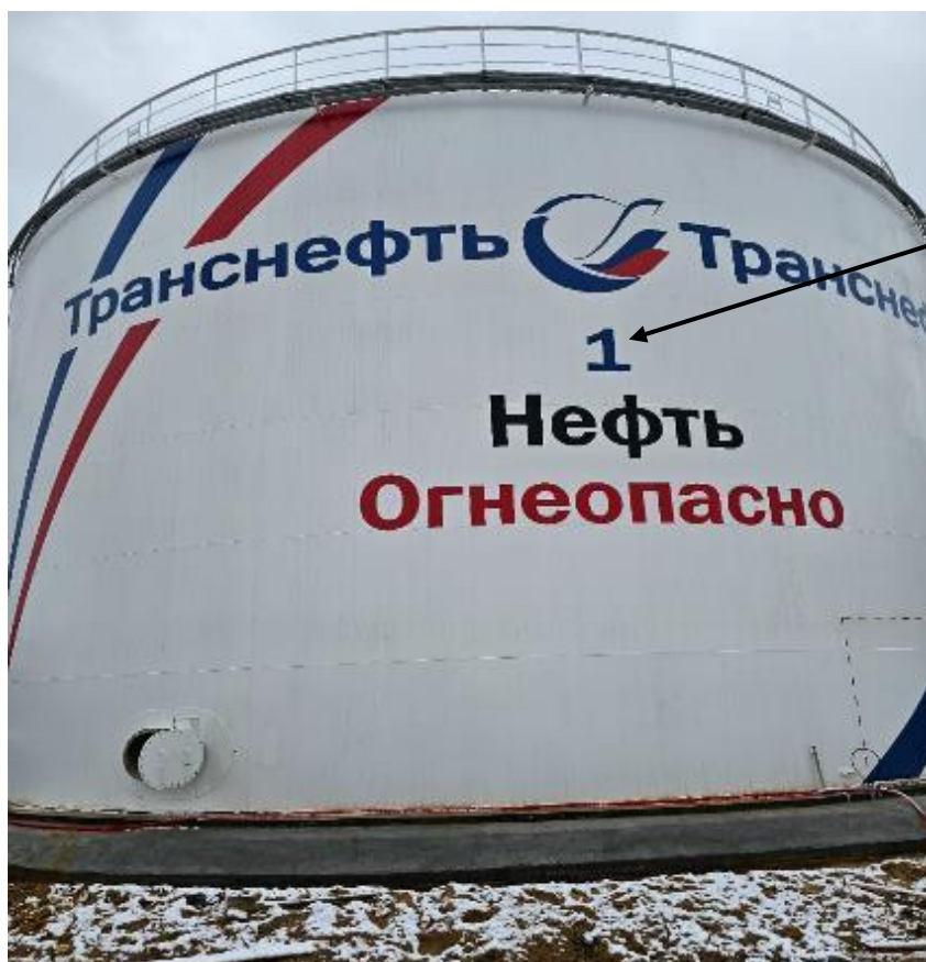
Рисунок 1 – Общий вид резервуара РВС-5000 зав. № 1 с люком
