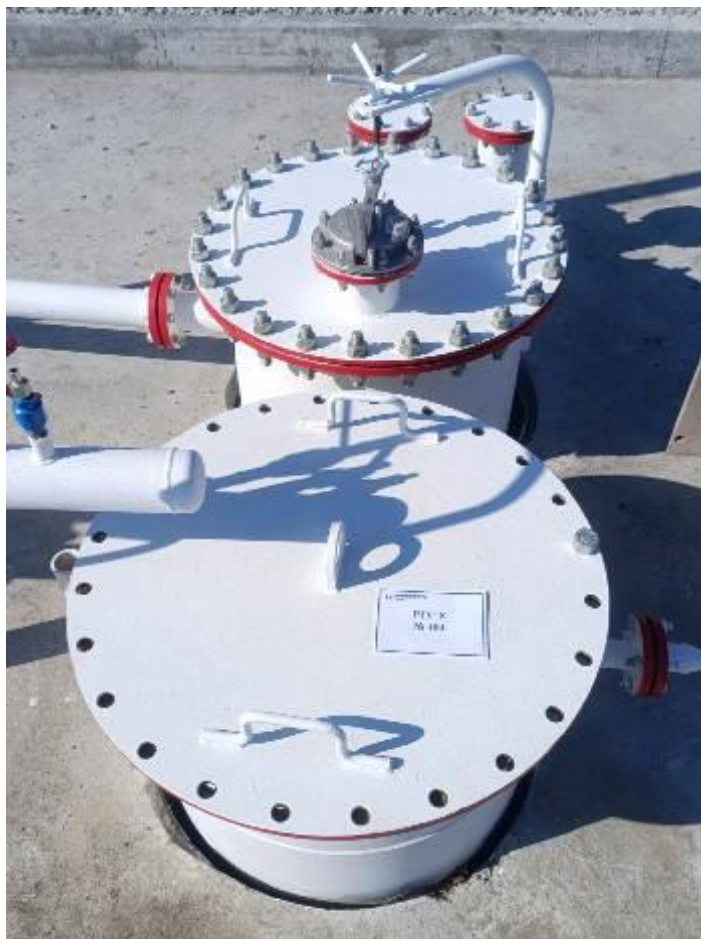
Рисунок 2 – Фотография маркировочной таблички, горловины и крышки замерного люка резервуара
