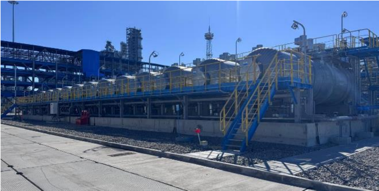
Рисунок 2 – Общий вид резервуаров РГС-100
