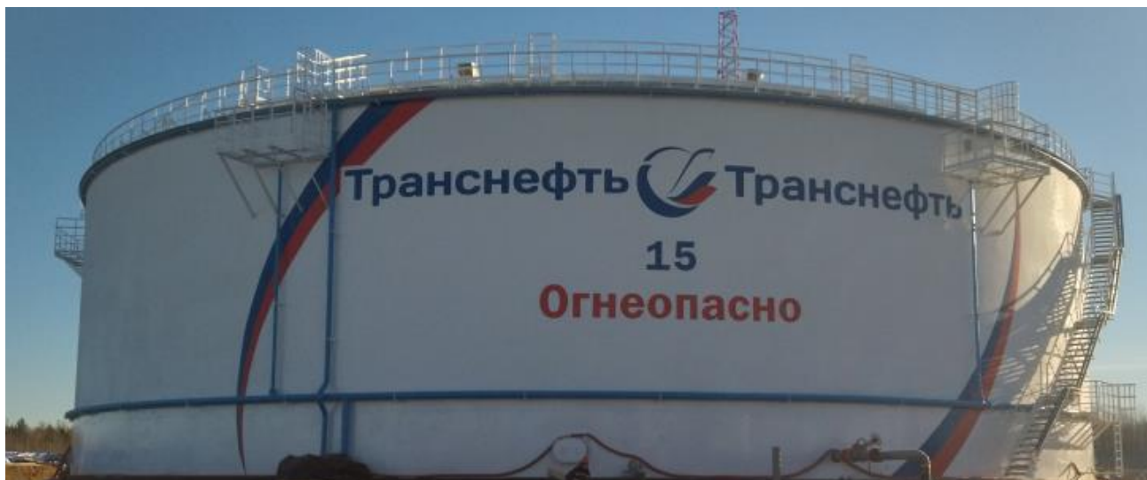
Рисунок 1 – Общий вид резервуара РВСП-20000 № 15
