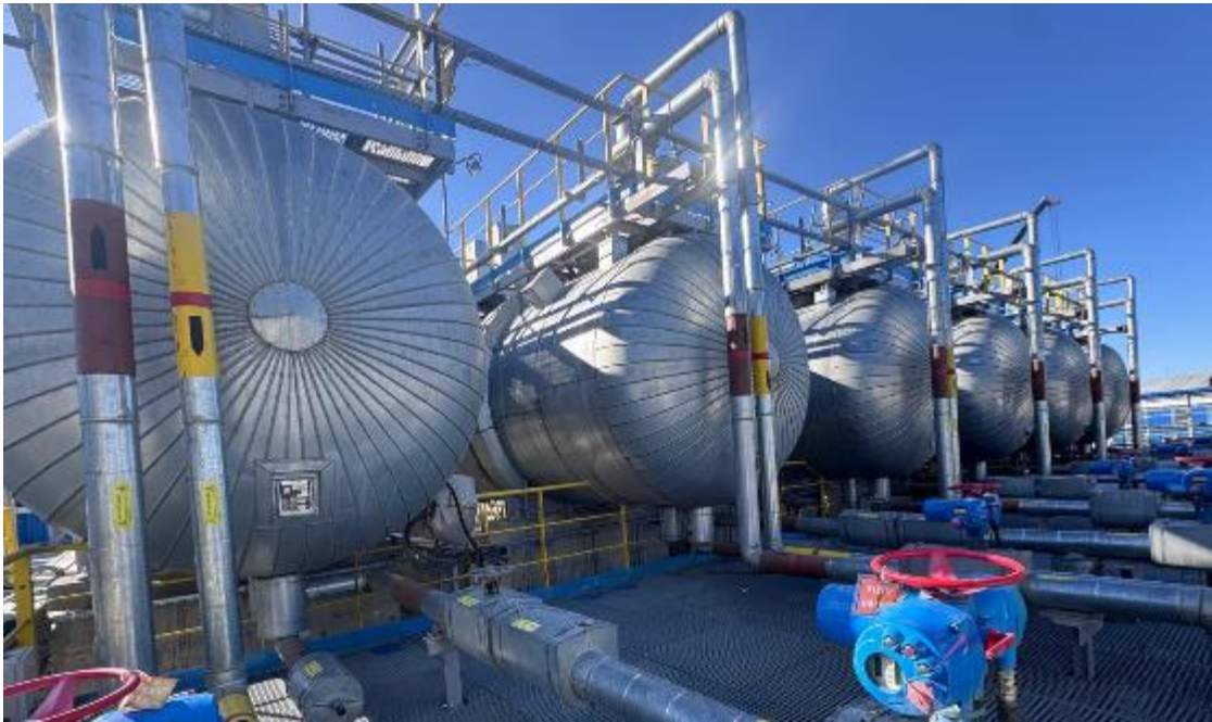
Рисунок 2 – Общий вид резервуаров РГС-100
