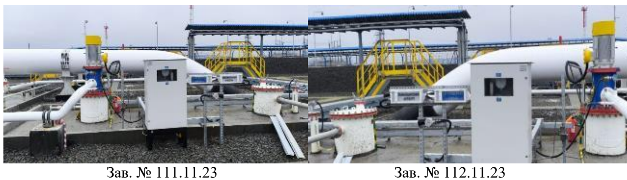
Рисунок 3 – Общий вид резервуаров с измерительными люками и горловинами
