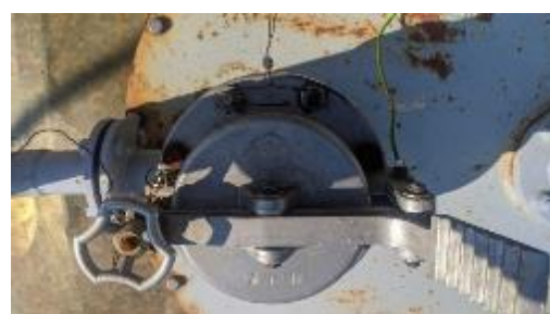
Рисунок 3 – Замерные люки резервуаров
