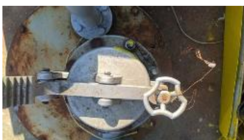
Рисунок 3 – Замерные люки резервуаров
