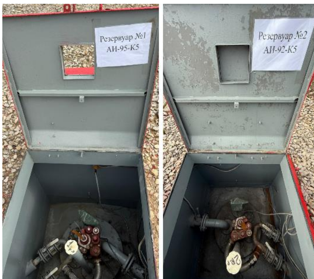
Рисунок 2 – Горловины резервуаров РГС-50 зав.№№ 1, 2
