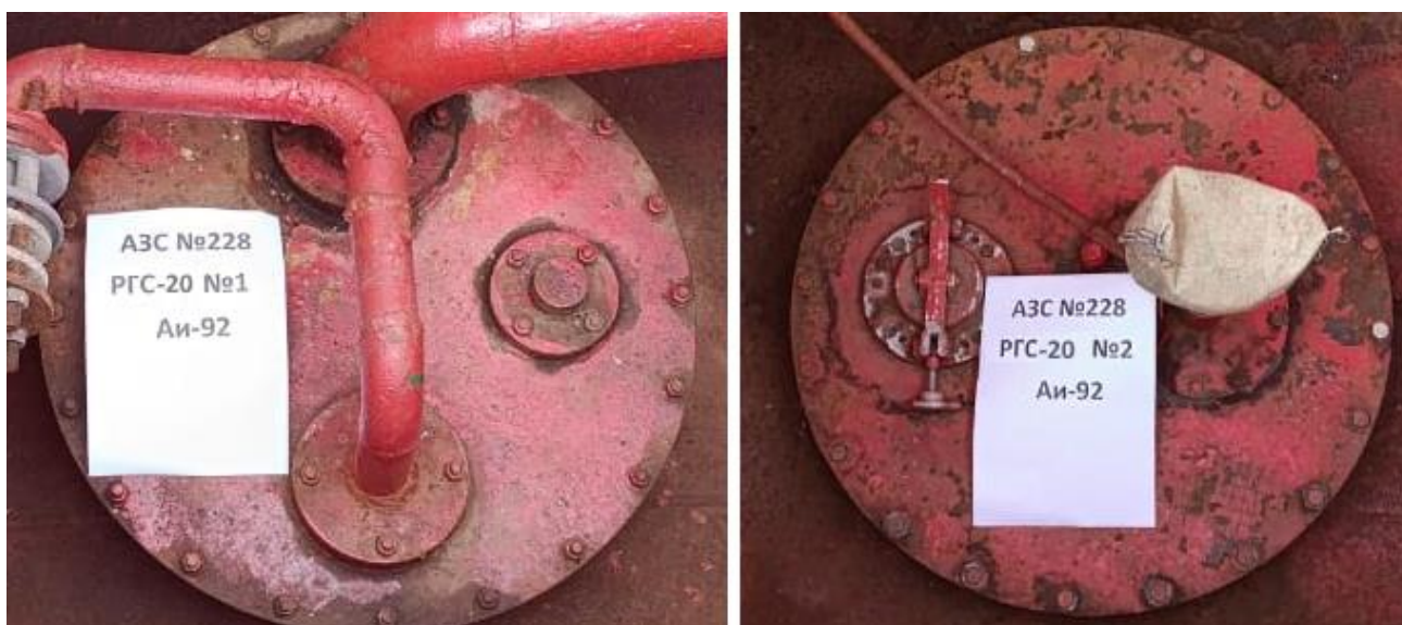
Рисунок 4 – Горловины резервуаров РГС-20 зав.№№ 1, 2
