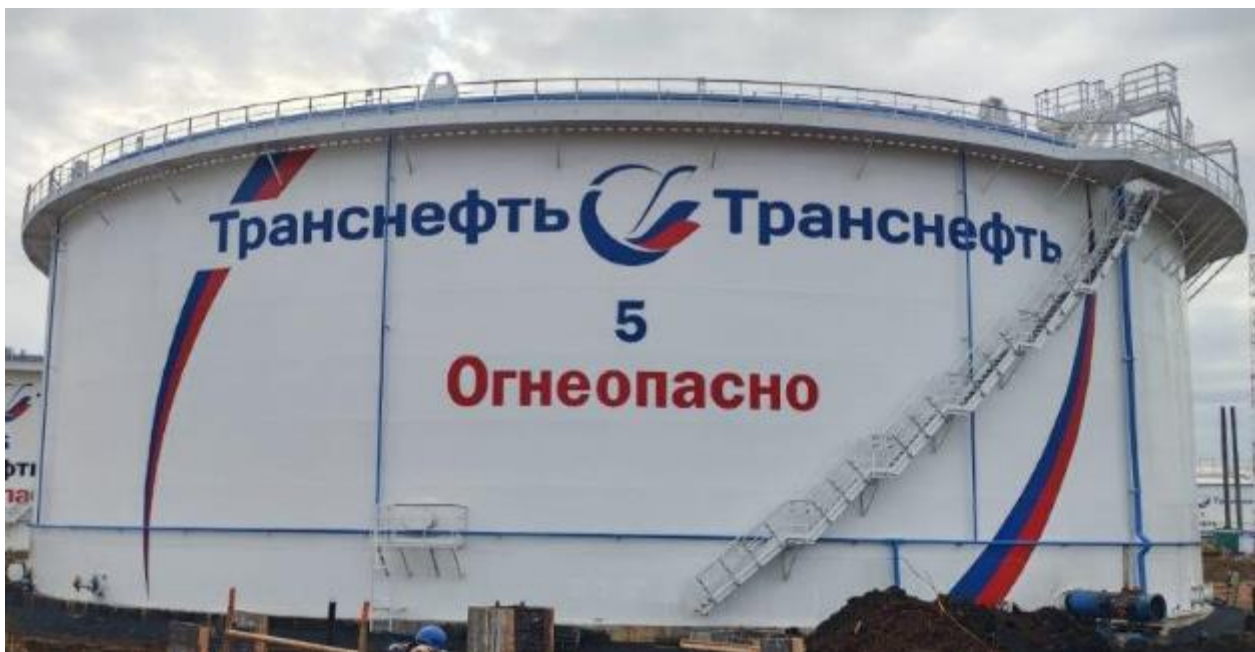
Рисунок 1 – Общий вид резервуара РВСПК-50000 № 5
