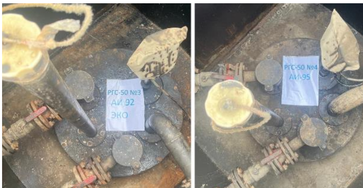
Рисунок 3 – Горловины резервуаров РГС-50 зав.№№ 3, 4
