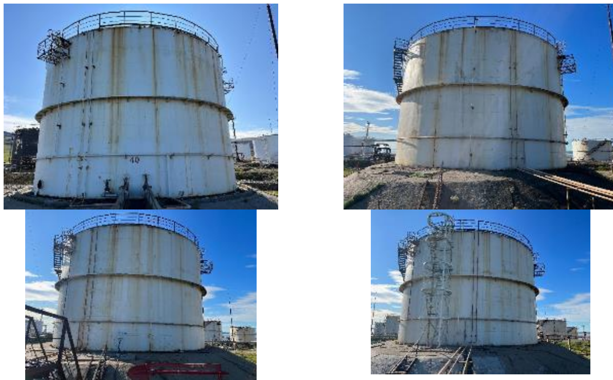
Рисунок 3 – Общий вид резервуаров вертикальных стальных цилиндрических РВС, РВС-3000 зав.№№ 40, 53, 54, 55 с указанием места нанесения заводских номеров
