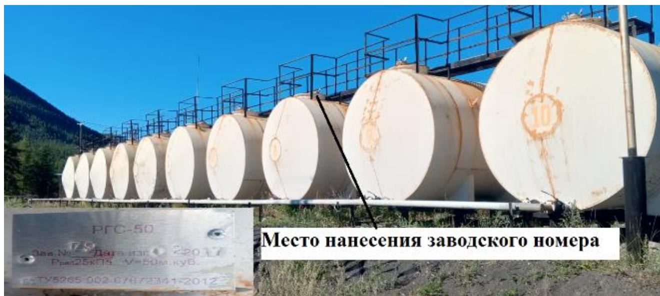
Рисунок 1 – Общий вид резервуаров горизонтальных стальных цилиндрических РГС-50 с указанием места нанесения заводских номеров
