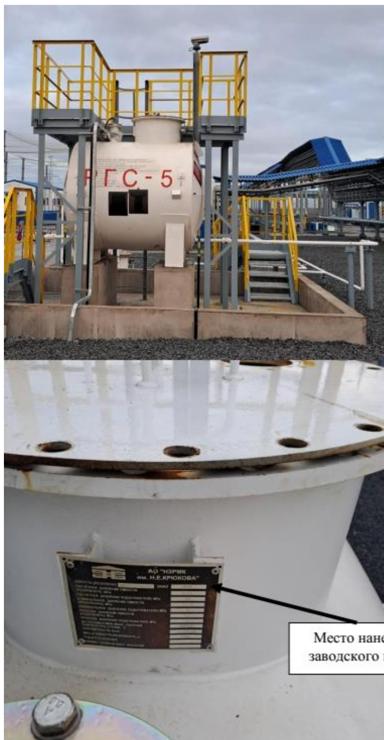
Рисунок 1 – Общий вид резервуара горизонтального стального РГС-5-А-С0-У1 зав. № 7294
