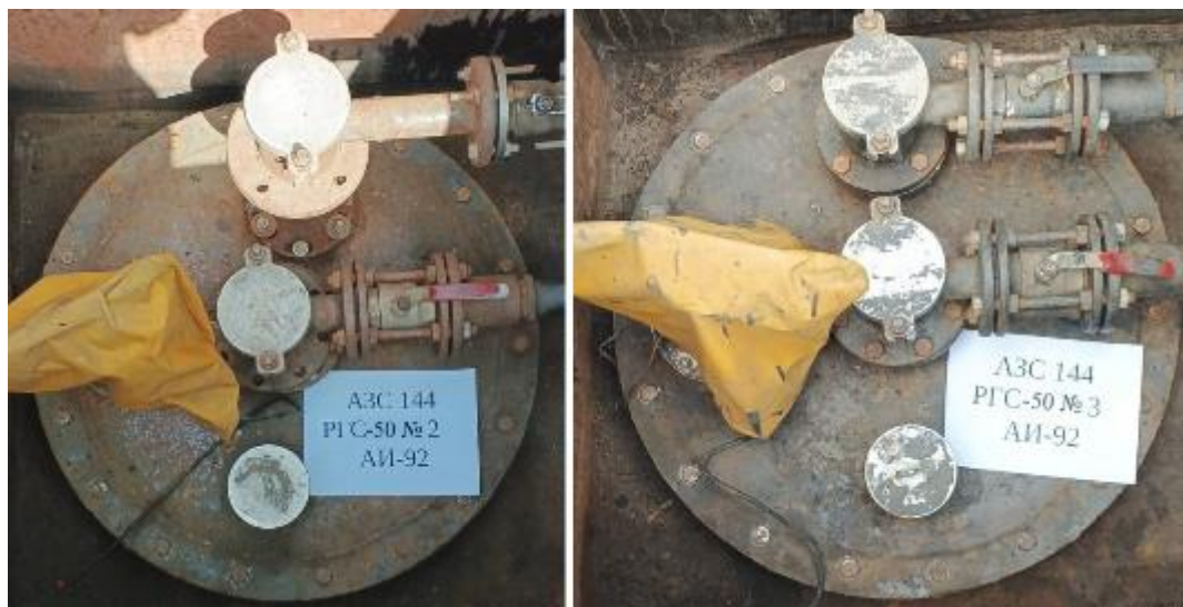
Рисунок 2 – Горловины резервуаров РГС-50 зав.№№ 2, 3
