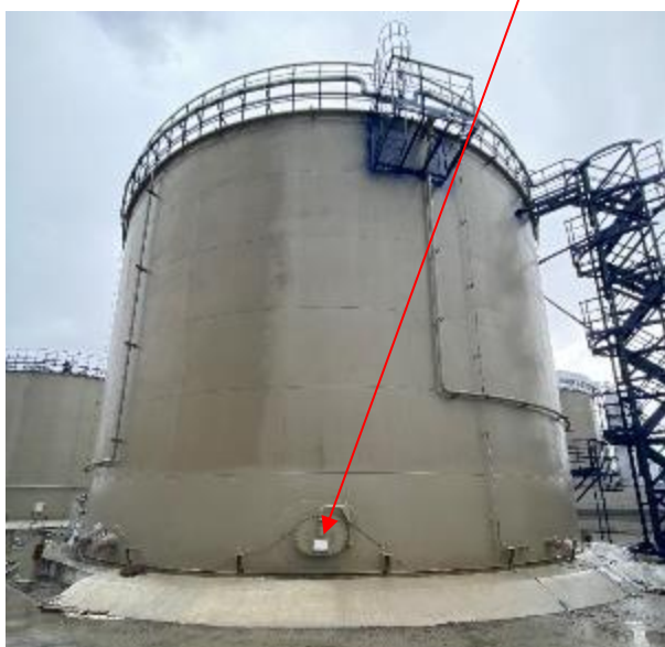
Рисунок 3 – Внешний вид резервуара РВСП-3000, заводской номер 23303 поз.7
