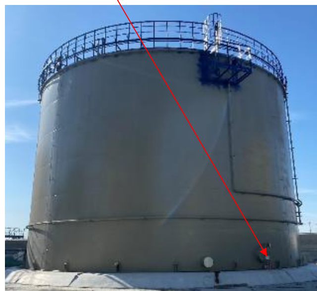
Рисунок 4 – Внешний вид резервуара РВСП-3000, заводской номер 23303 поз.8
