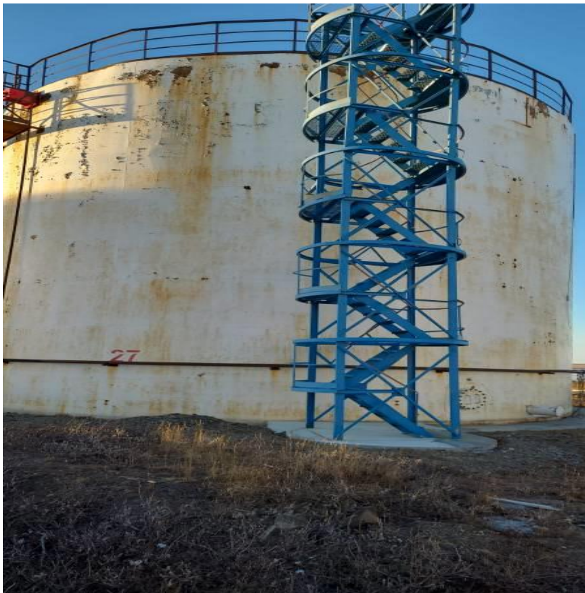
Рисунок 1 – Общий вид резервуара вертикального стального цилиндрического РВС-2000 зав.№27 с указанием места нанесения заводского номера
