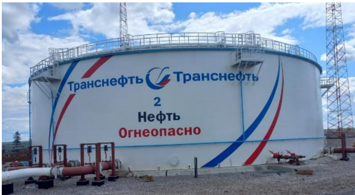
Рисунок 1 – Общий вид резервуара РВС-20000 № 2
