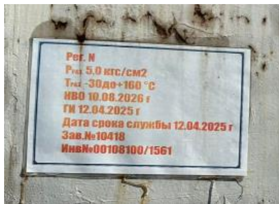
Рисунок 4 – Вид замерного люка и место нанесения заводского номера резервуара горизонтального стального РГС-60 заводской номер 10418
