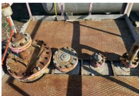
Рисунок 2 – Вид замерного люка и место нанесения заводского номера резервуара горизонтального стального РГС-60 заводской номер 7416
