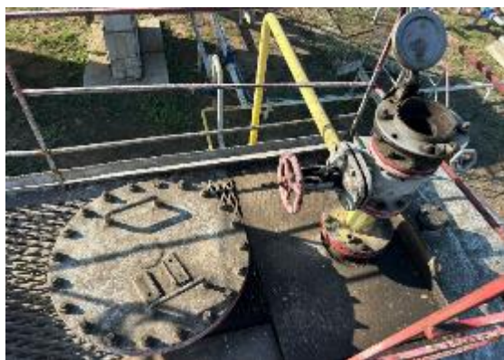
Рисунок 4 – Вид замерного люка и место нанесения заводского номера резервуара горизонтального стального РГС-60 заводской номер 10418
