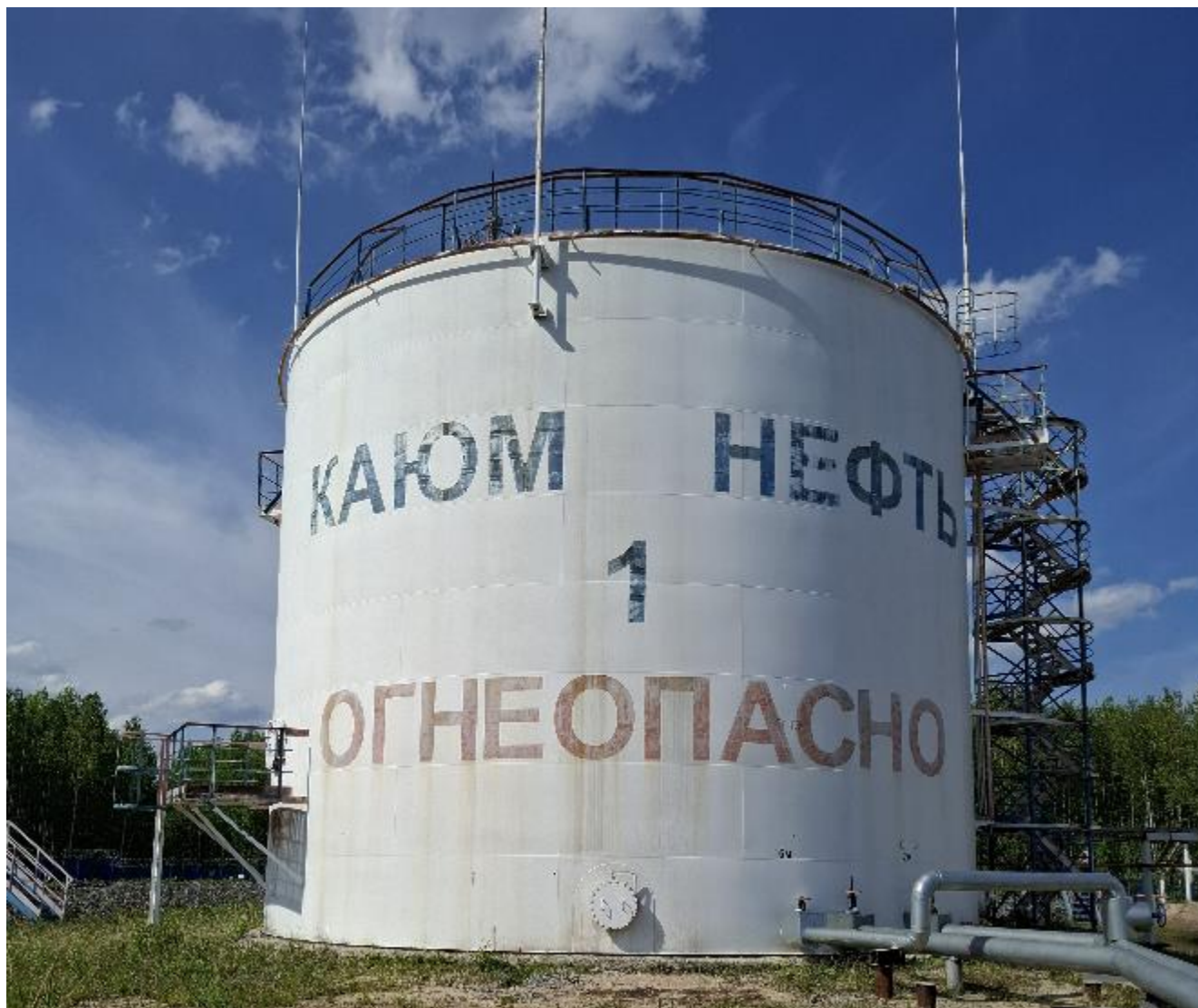
Рисунок 1 – Общий вид РВС
