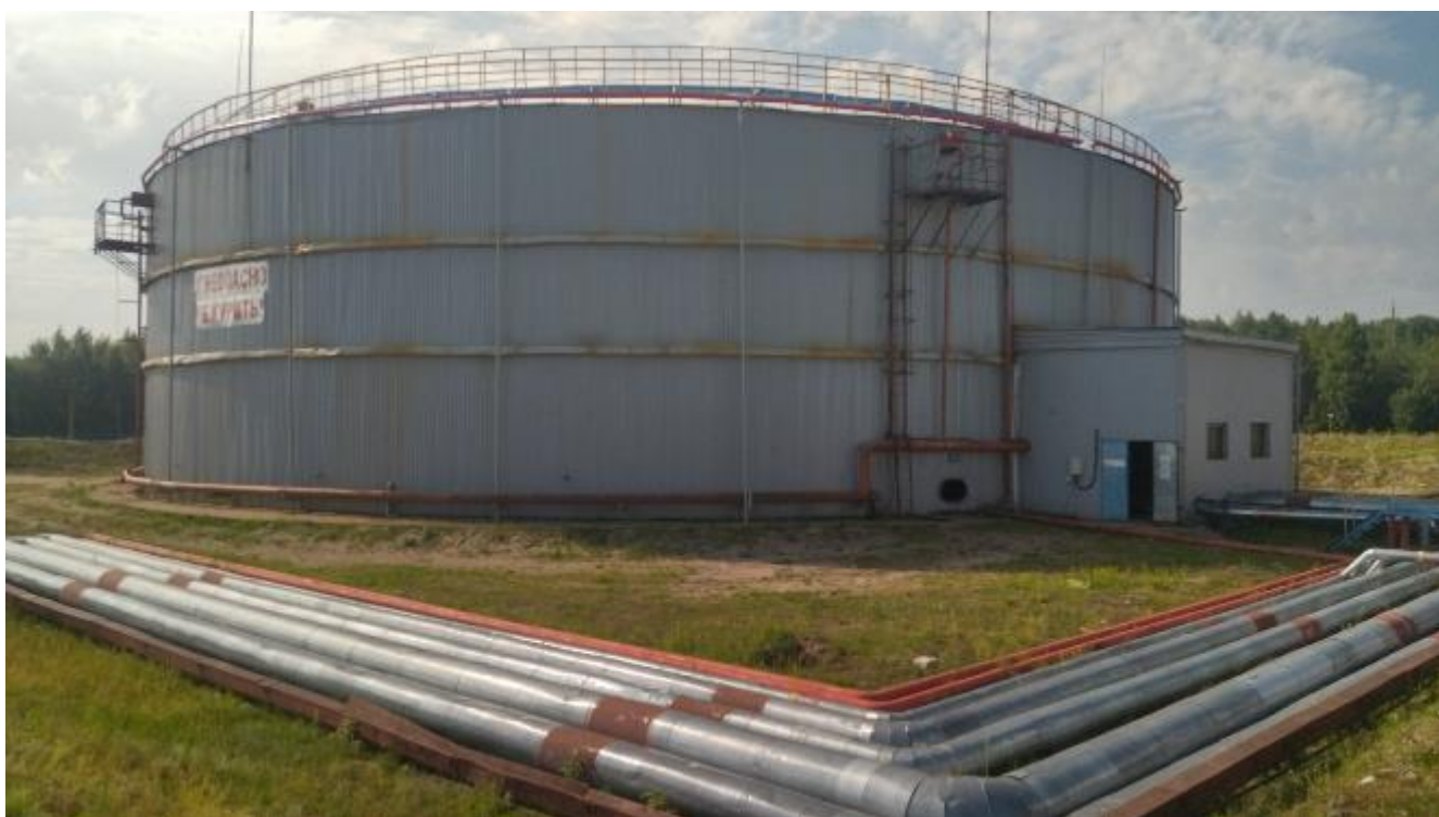
Рисунок 2 – Общий вид резервуара РВС-20000 № 2
