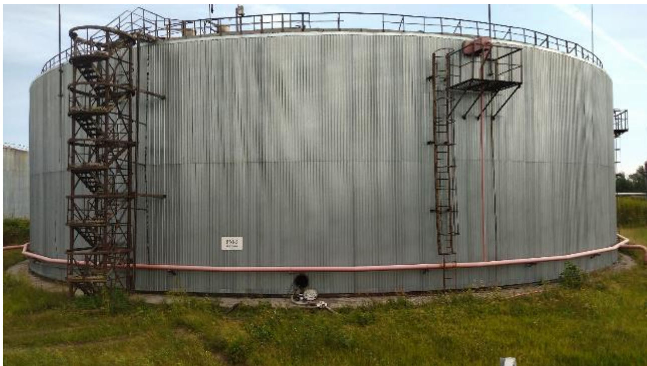
Рисунок 2 – Общий вид резервуара РВС-20000 № РМ-5
