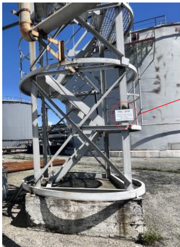
Рисунок 3 – место установки металлических табличек, содержащих заводские номера резервуаров стальных вертикальных цилиндрических РВС-3000
