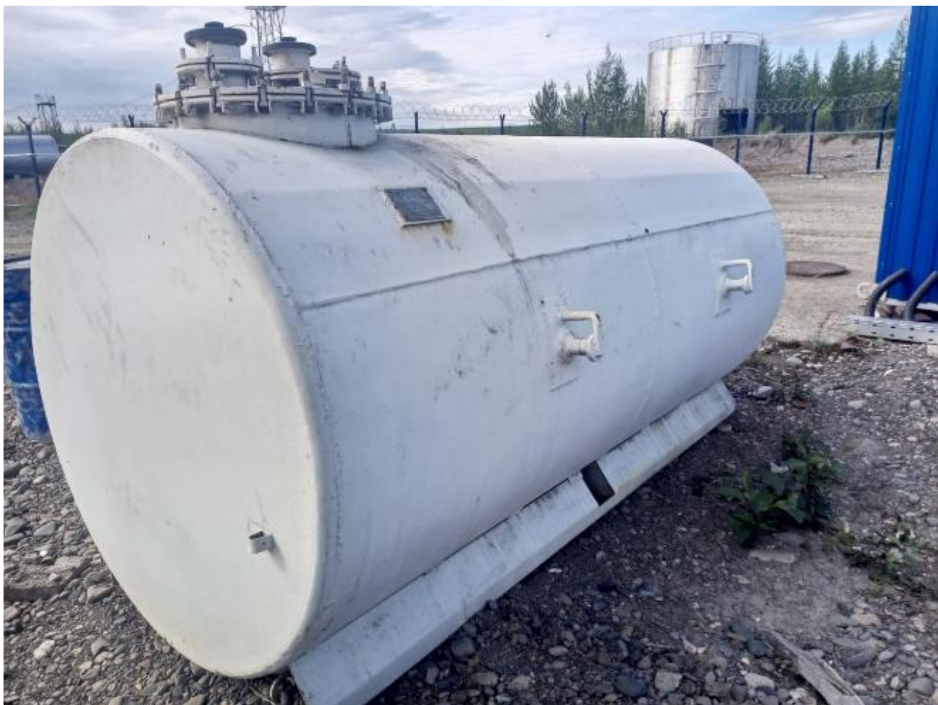
Рисунок 2 – Общий вид резервуара Р-4 зав.№ 148
