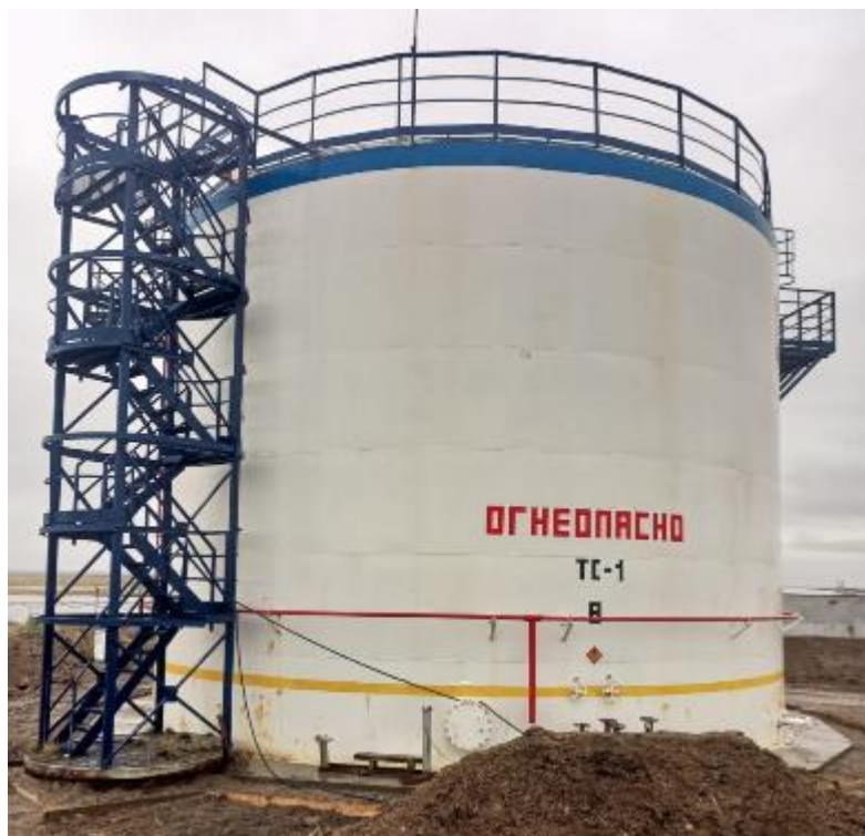
Рисунок 1 – Общий вид резервуара РВС-1000 № 8
