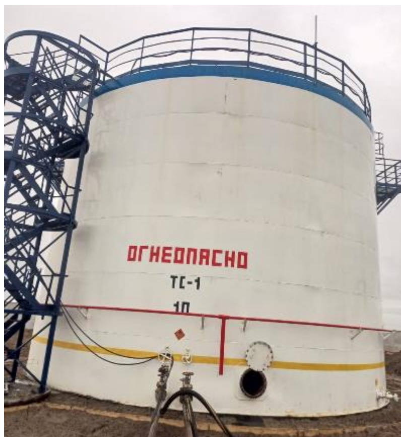
Рисунок 2 – Общий вид резервуара РВС-1000 № 10
