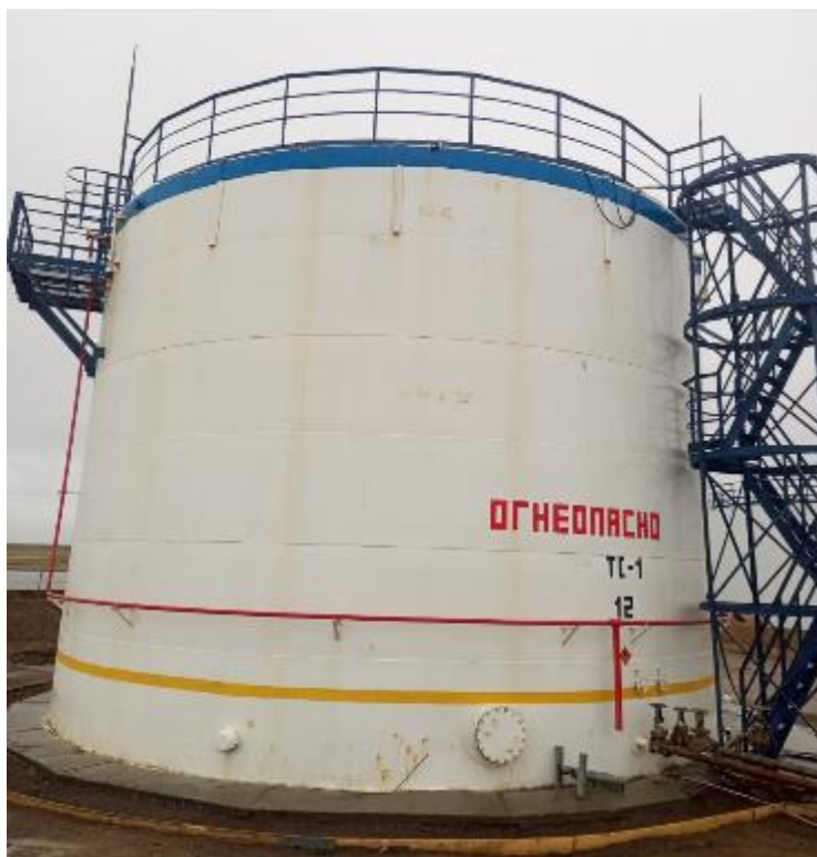
Рисунок 3 – Общий вид резервуара РВС-1000 № 12
