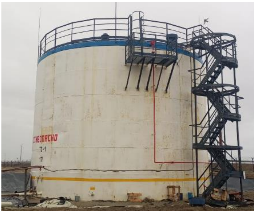
Рисунок 5 – Общий вид резервуара РВС-1000 № 17
