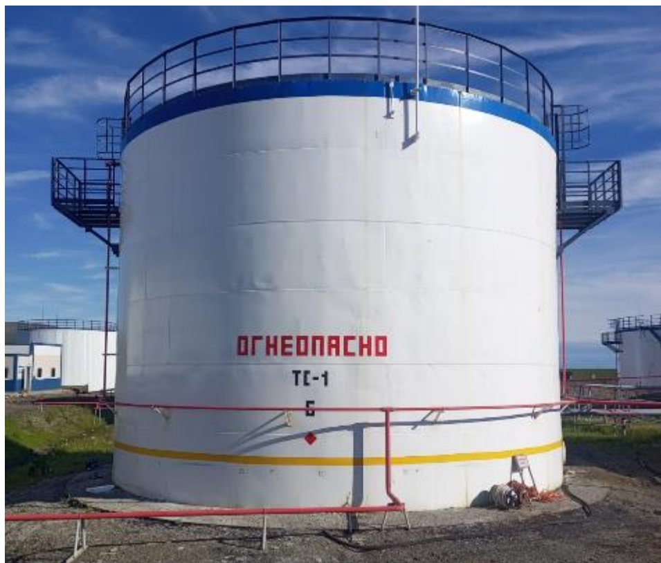
Рисунок 1 – Общий вид резервуара РВС-1000 № 6
