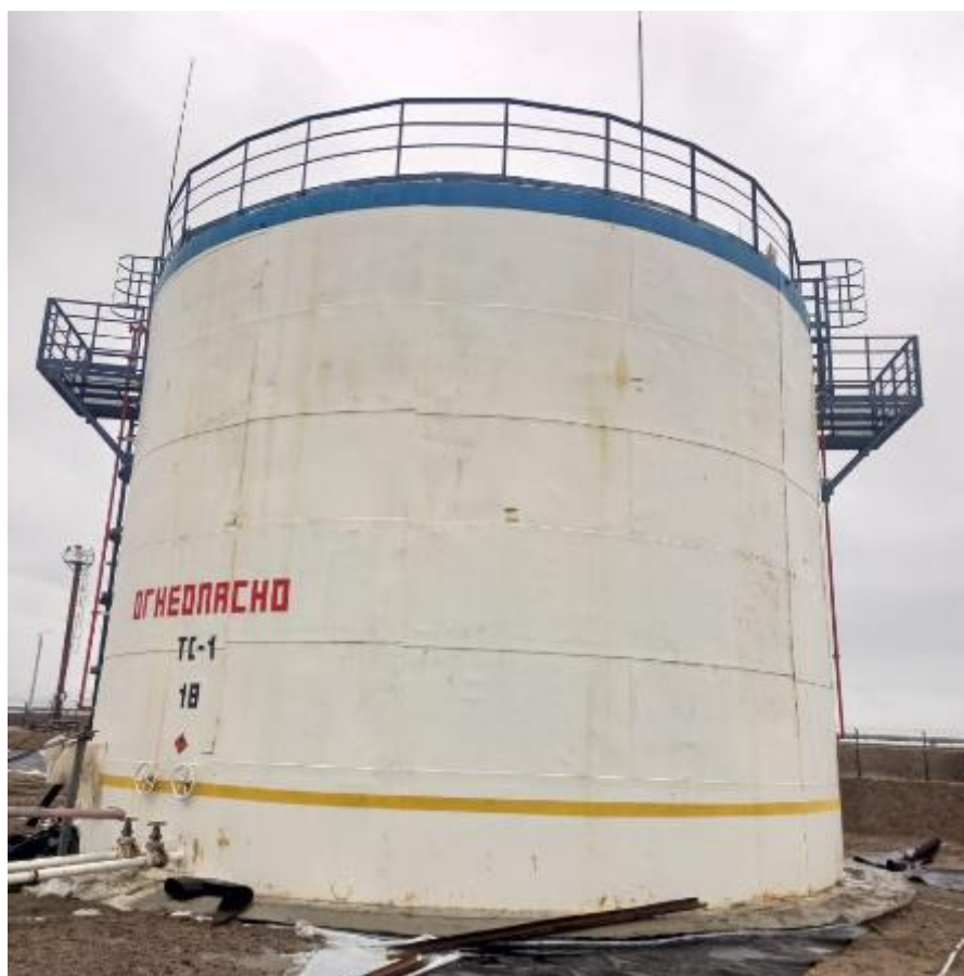
Рисунок 6 – Общий вид резервуара РВС-1000 № 18
