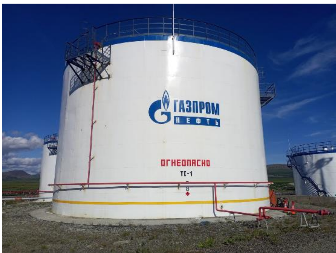
Рисунок 2 – Общий вид резервуара РВС-3000 № 8
