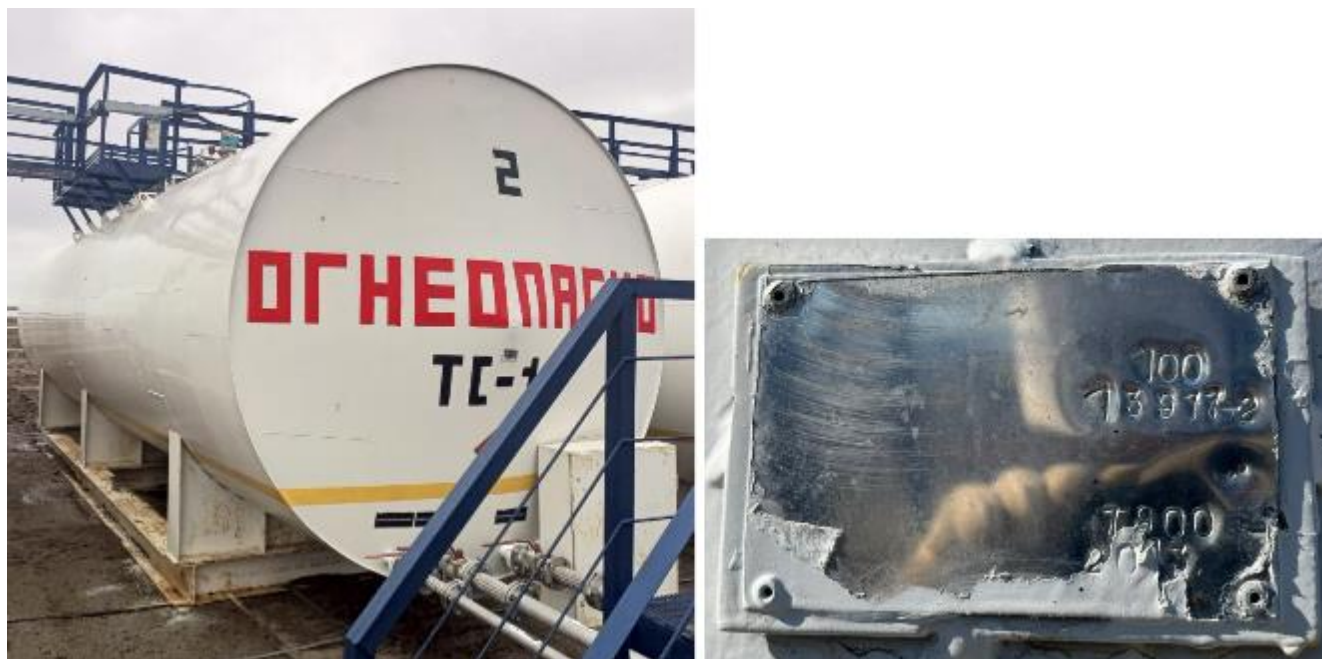
Рисунок 3 – Общий вид резервуара и маркировочной таблички РГС-100 зав. № 13977-2
