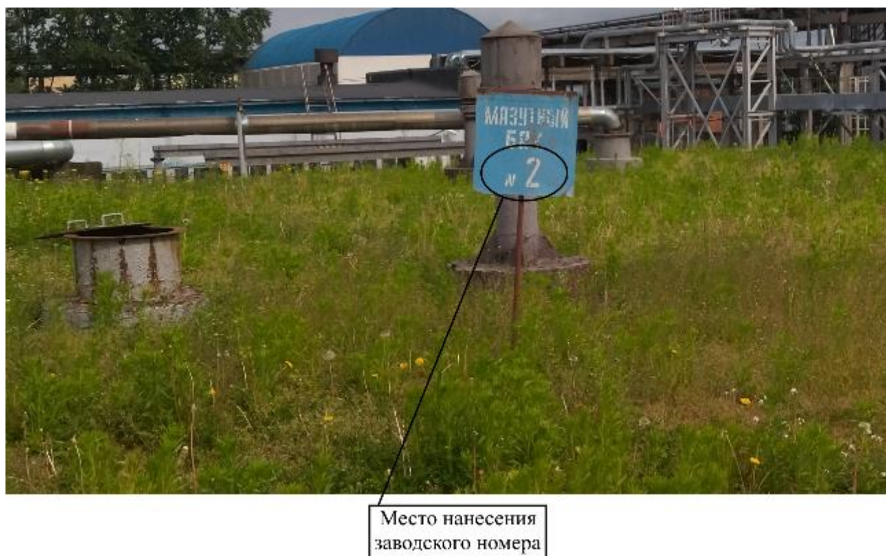
Рисунок 3 – Место нанесения заводского номера
