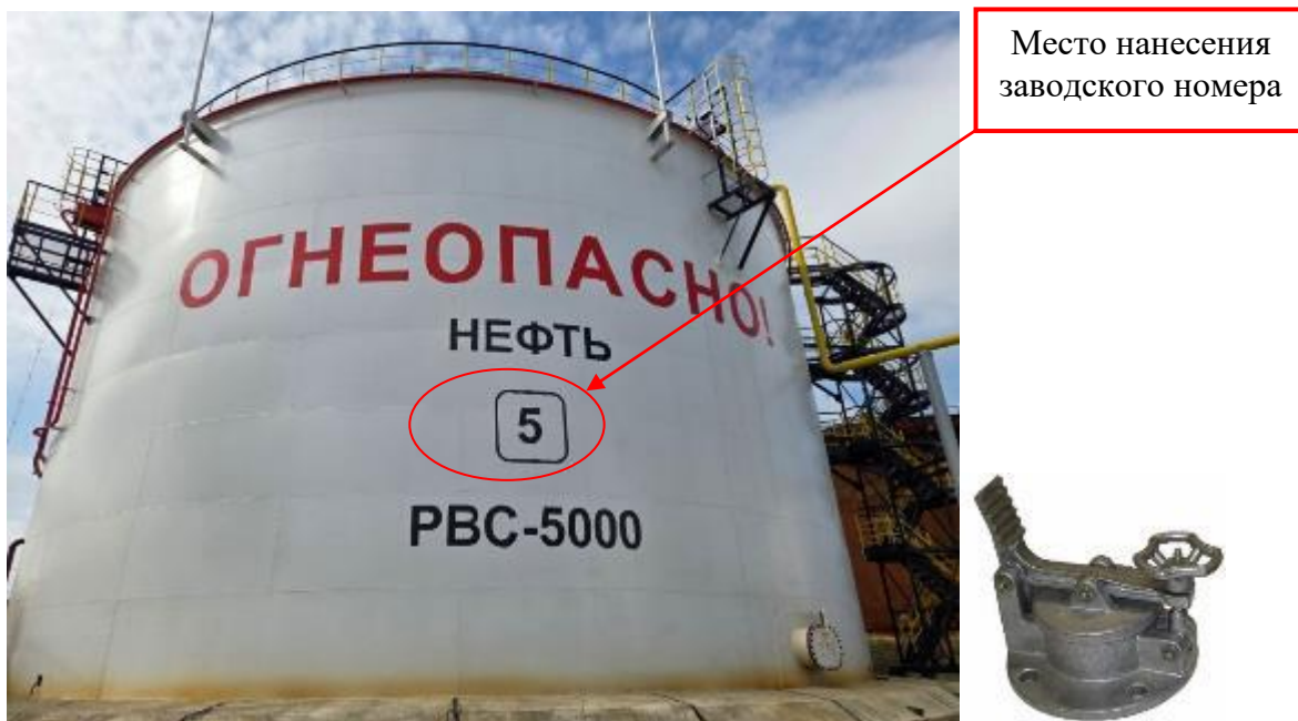
Рисунок 1 – Общий вид резервуара и замерного люка РВС-5000 зав.№ 5
