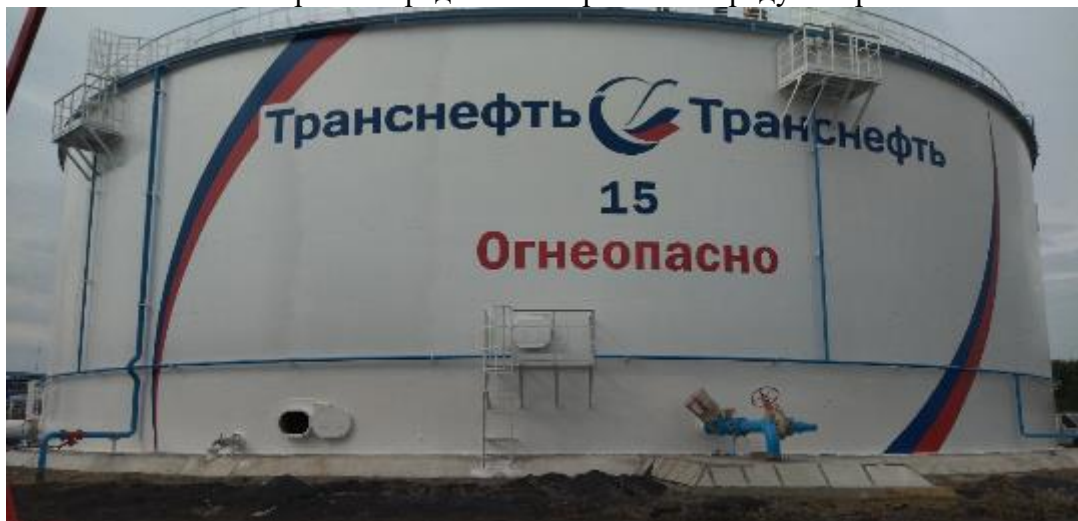
Рисунок 1 – Общий вид резервуара РВСП-20000 № 15
