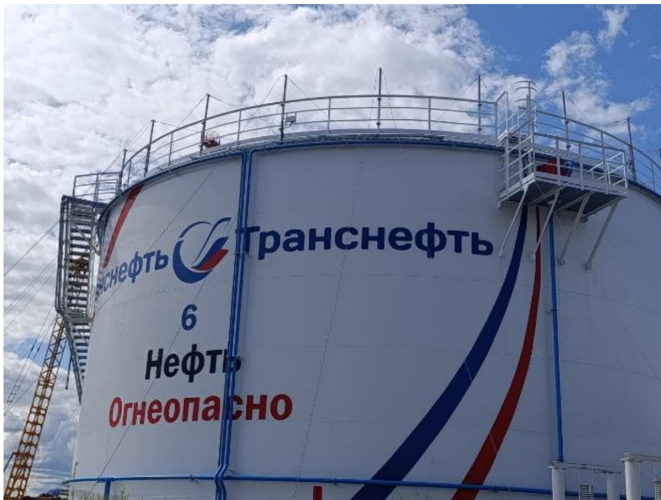
Рисунок 1 – Общий вид резервуара РВС-5000 № 6
