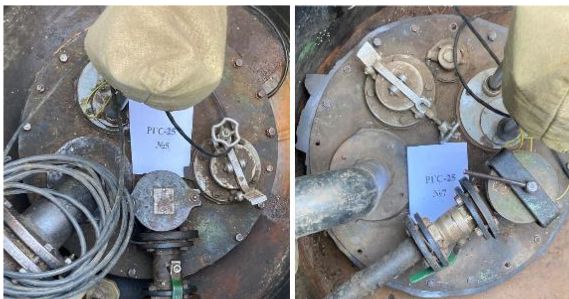
Рисунок 3 – Горловины резервуаров РГС-25 зав.№№ 5, 7
