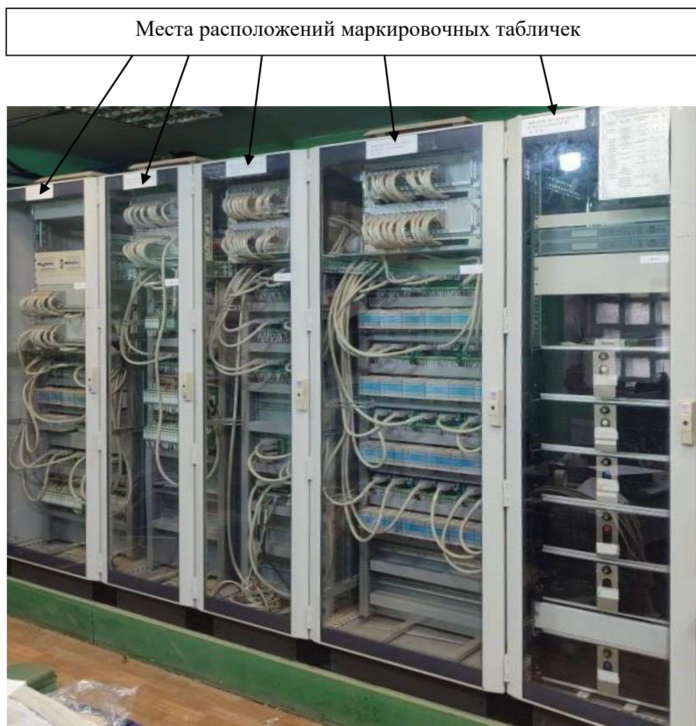
Рисунок 2 – Внешний вид электротехнических шкафов с указанием мест расположений маркировочных табличек
