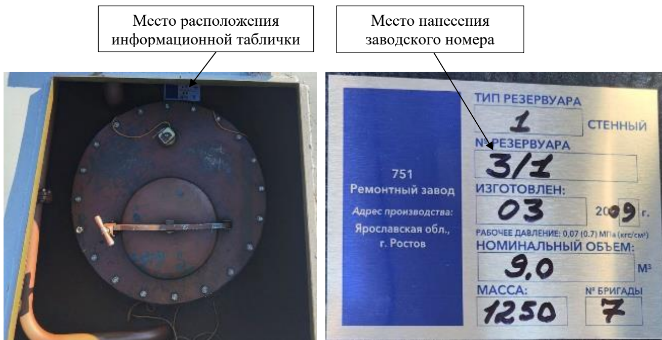
Рисунок 2 – Общий вид горловины резервуара № 3/1, обозначение места нанесения заводского номера на информационную табличку
