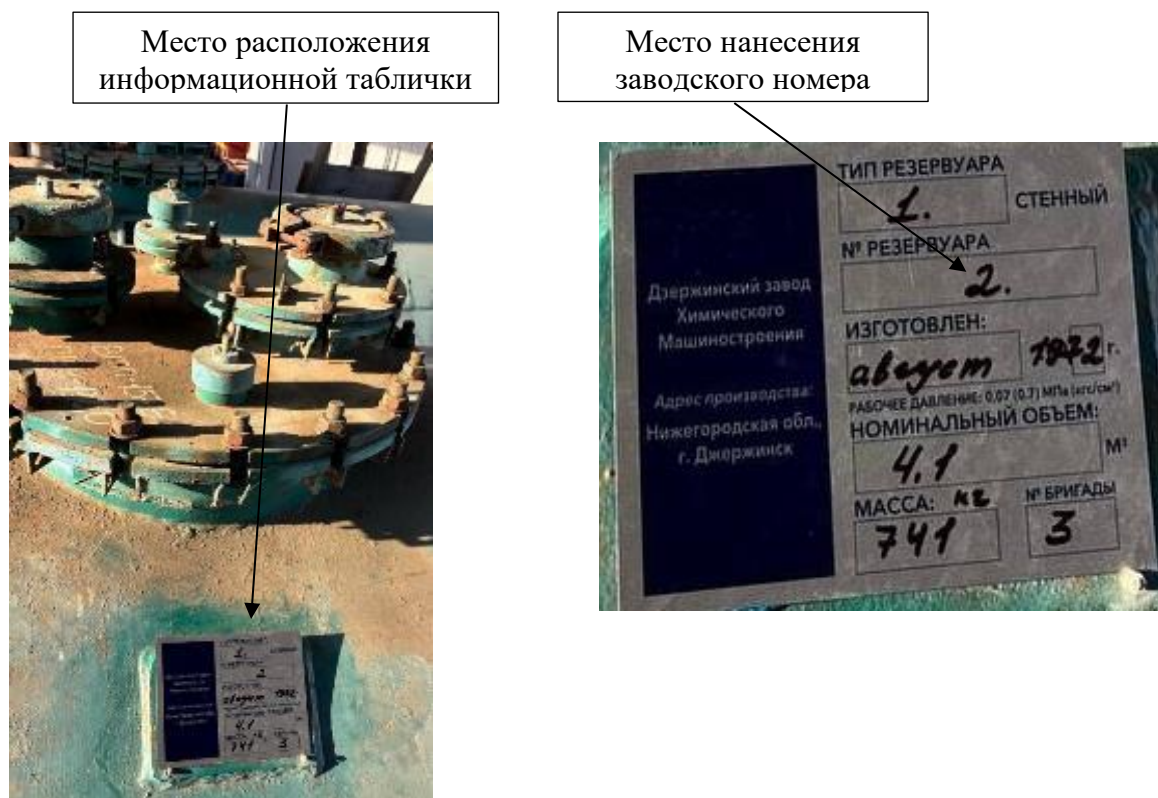
Рисунок 3 – Общий вид горловины и замерного люка резервуара № 2, обозначение места нанесения заводского номера на информационную табличку
